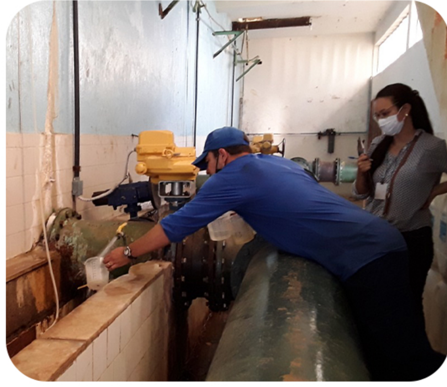
Janeiro | Fiscalização em Ponte Nova
