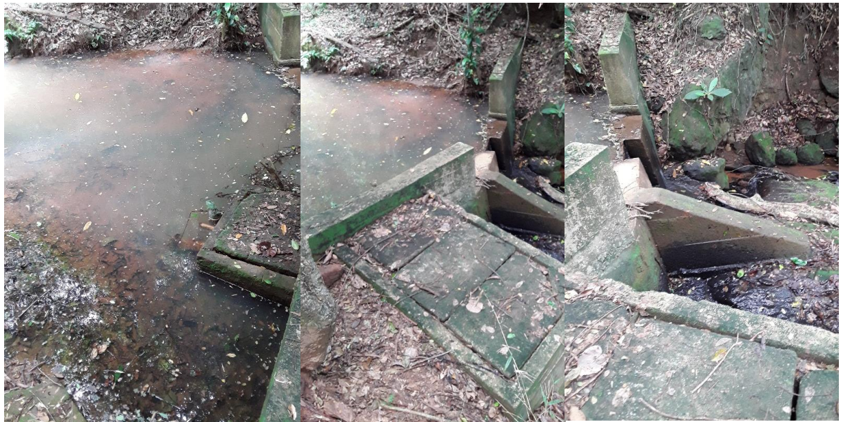
Figura 62 – Barragem de acumulação
