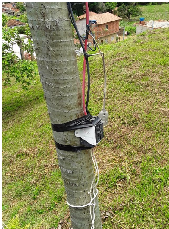
Figura 79 – Painel de controle do conjunto moto bomba
