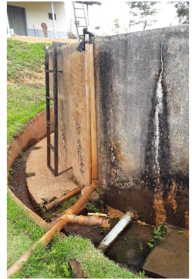
Figura 70 – Infiltrações na estrutura dos floculadores e decantador
