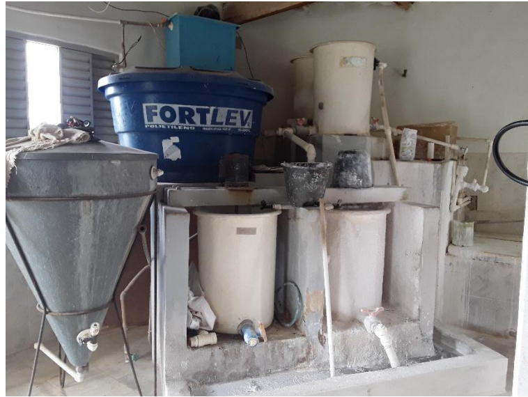
Figura 43 – Preparo do sulfato de alumínio e da cal
