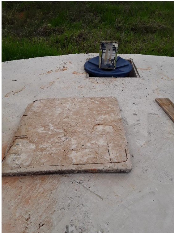
Figura 41 – Tampa de inspeção do reservatório apoiado
