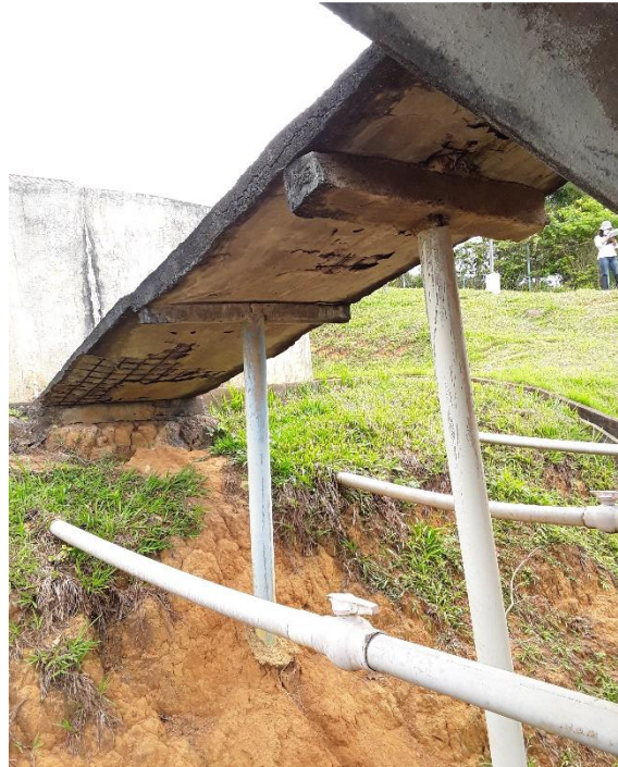
Figura 73 – Rampa de acesso a área dos filtros
