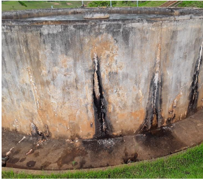
Figura 70 – Infiltrações na estrutura dos floculadores e decantador
