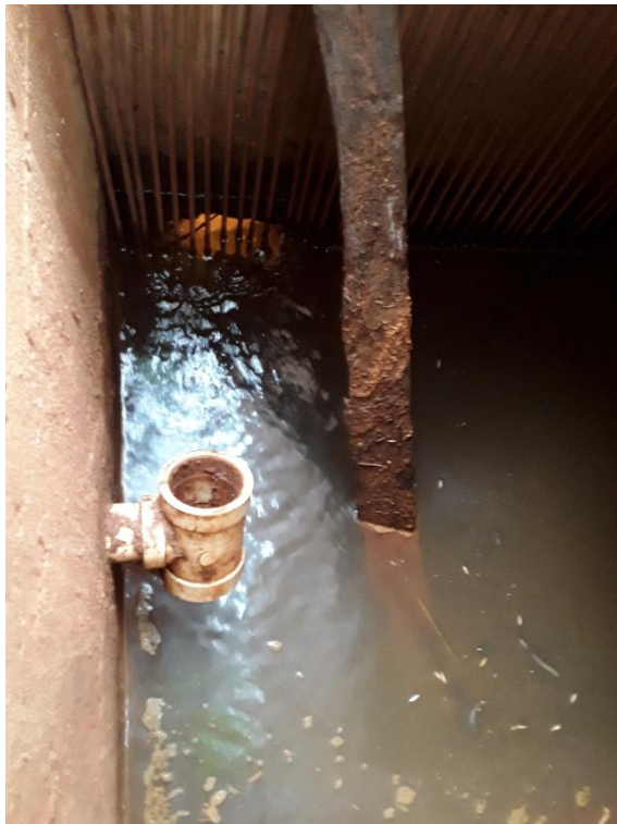
Figura 21 – Gradeamento no interior da caixa de passagem
