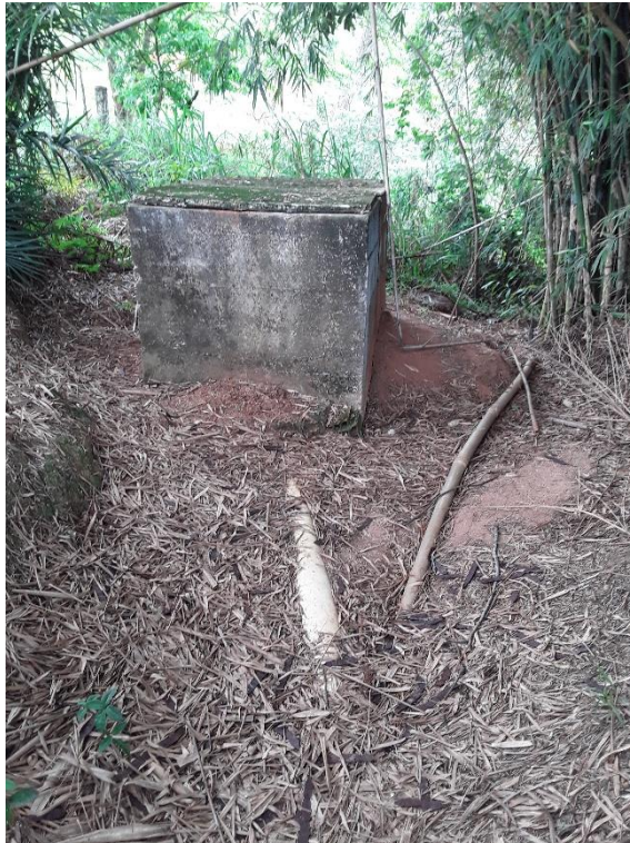
Figura 20 – Segunda caixa de passagem
