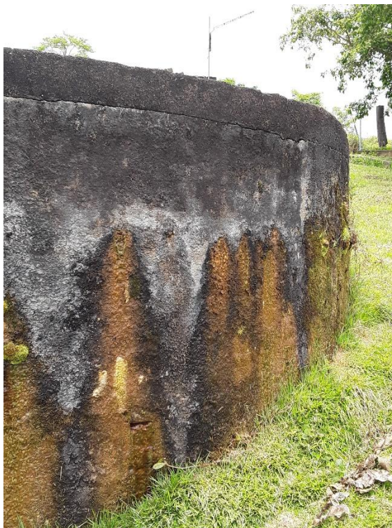
Figura 76 – Infiltrações do reservatório para armazenamento de água para lavagem dos filtros
