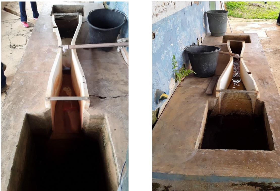
Figura 67 – Calha Parshall
