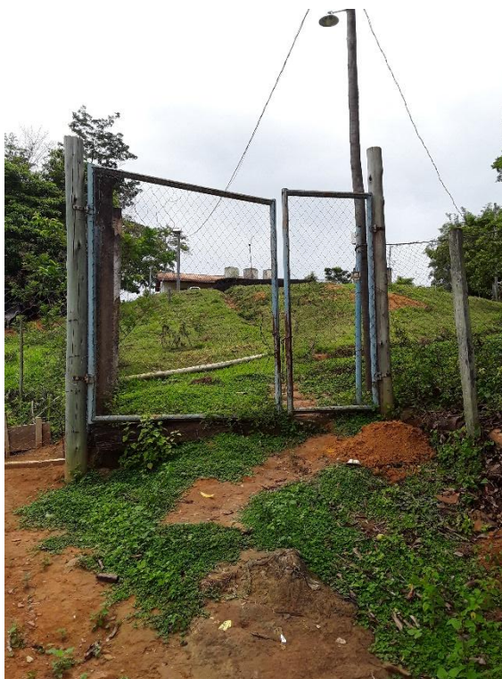
Figura 66 – Portão de acesso a área da ETA
