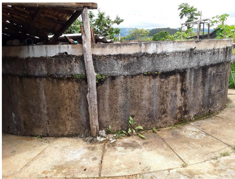
Figura 40 – Reservatório semienterrado
