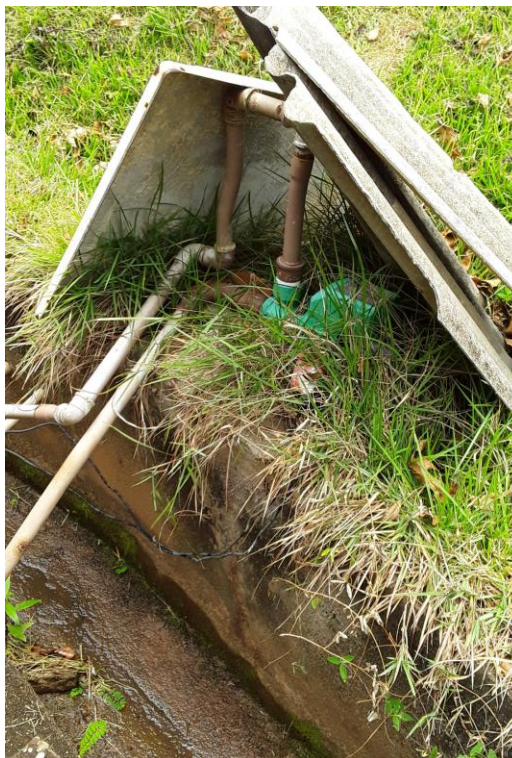
Figura 83 – Conjunto moto bomba para abastecer a casa de química
