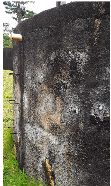
Figura 76 – Infiltrações do reservatório para armazenamento de água para lavagem dos filtros
