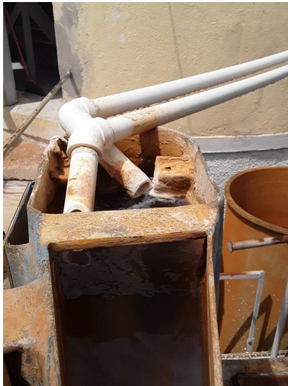
Figura 30 – Adição do sulfato de alumínio e da cal
