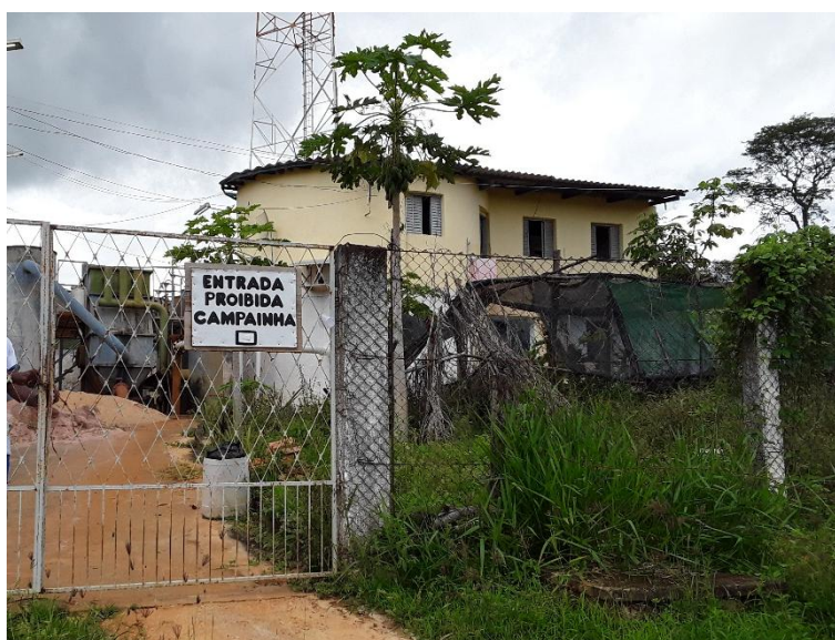
Figura 26 – Portão de entrada da ETA
