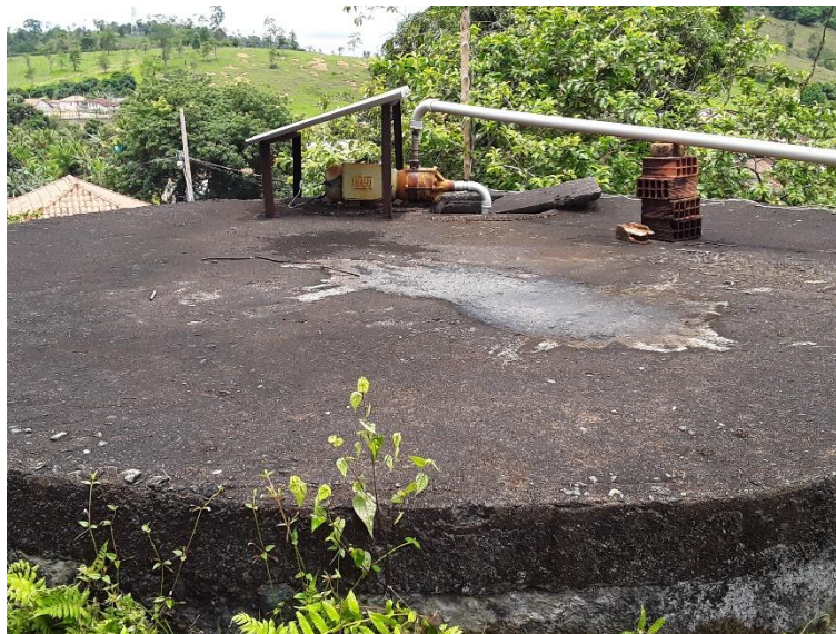
Figura 77 – Cobertura do reservatório para armazenamento de água para lavagem dos filtros
