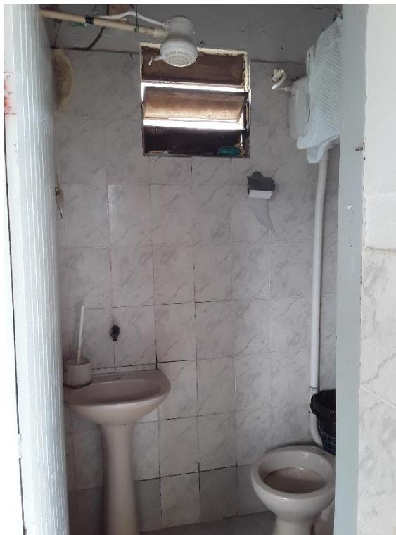
Figura 55 – Banheiro da ETA
