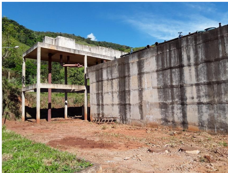
Figura 60 – Tratamento preliminar e reator UASB
