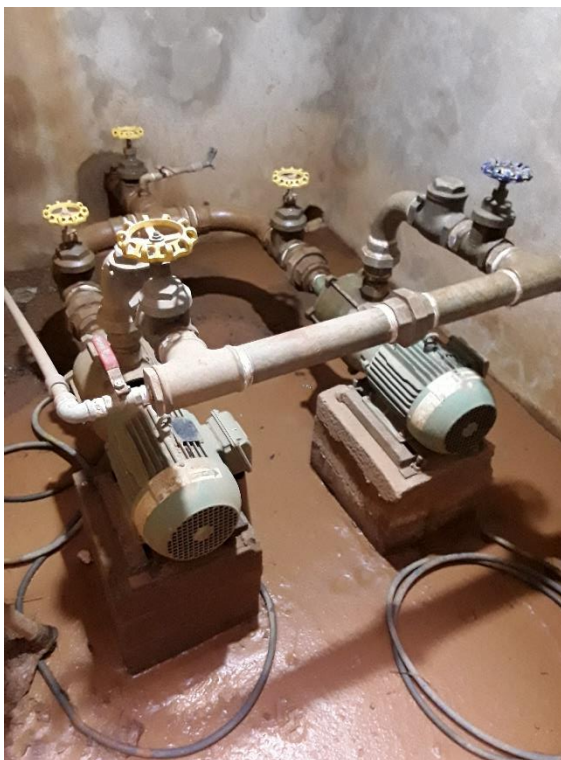
Figura 55 – Conjuntos motobomba - Planalto
