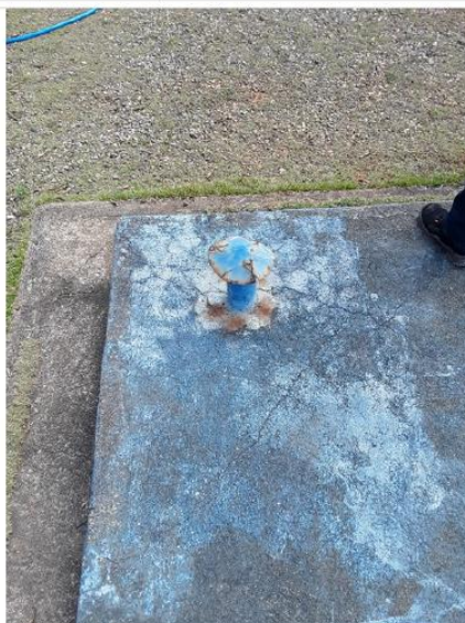
Tubulação de ventilação
