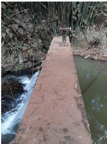
Barragem de captação
