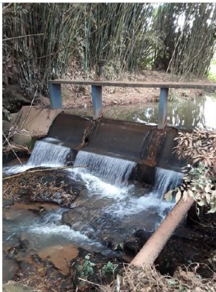
Barragem de Captação
