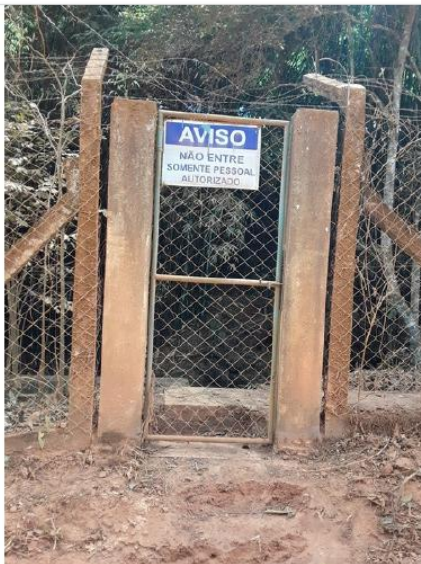
Entrada da captação
