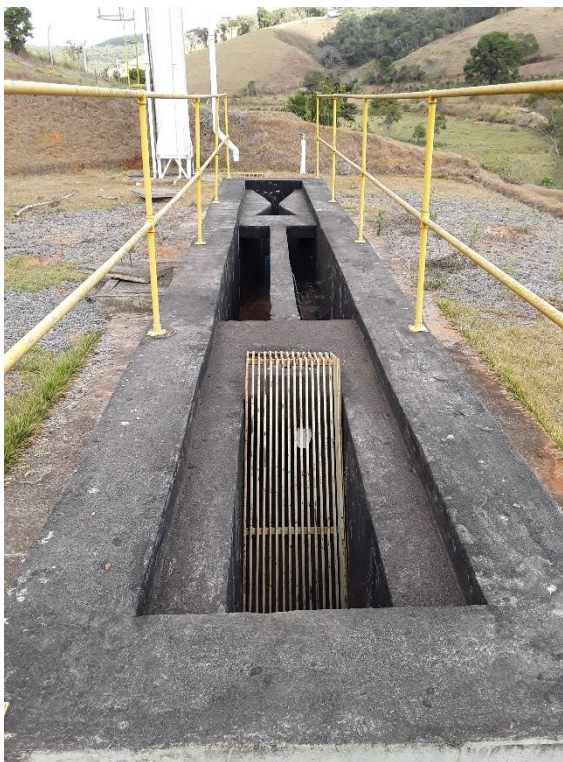
Figura 3 – Sistema de tratamento preliminar
