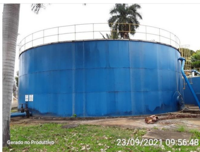
Reservatório Área da ETA
