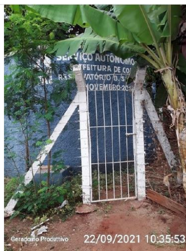
Reservatório São Vicente
