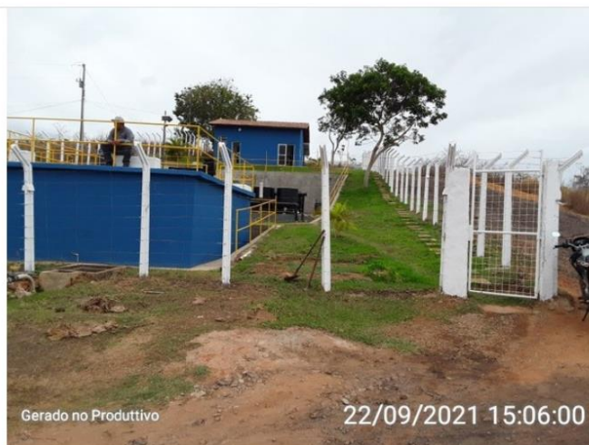
Acesso à ETA
