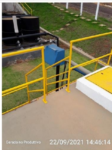
Guarda-corpo e corrimão da ETA
