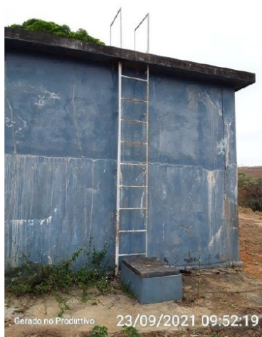
Escada de acesso ao reservatório
