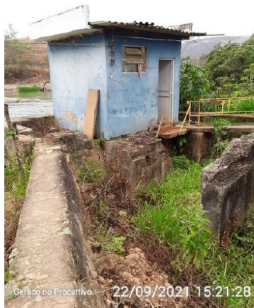
Captação Rio Caratinga - Barra do Cuieté
