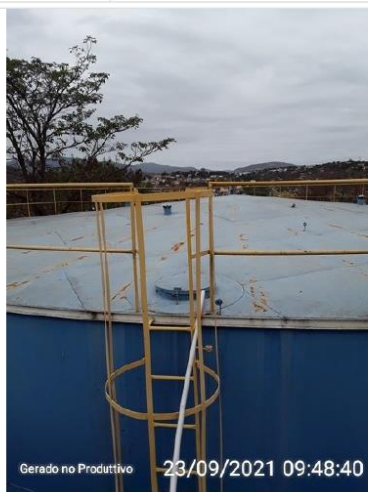
Tampa de inspeção do reservatório
