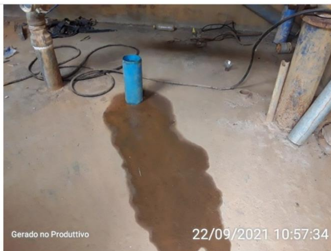
Laje sanitária de proteção
