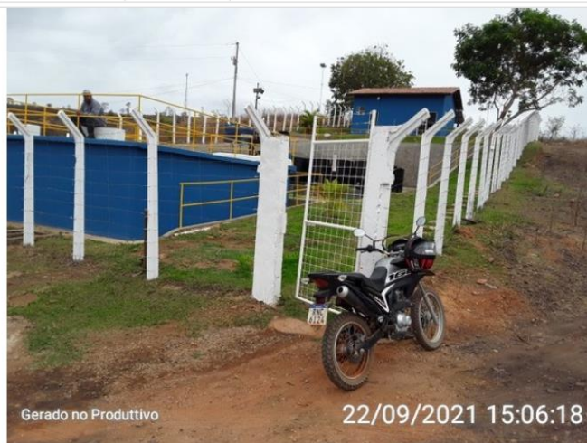
Portão de acesso à ETA
