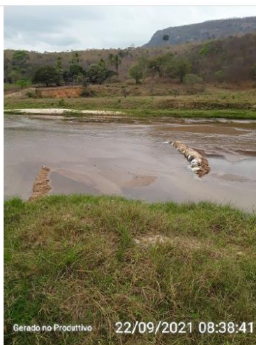
Assoreamento no manancial de captação
