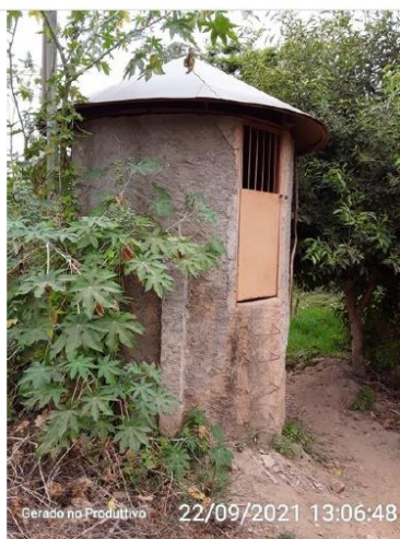
EEAB Captação Córrego da Penha Jusante
