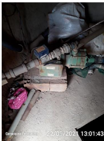
EEAB Captação Córrego da Penha Jusante
