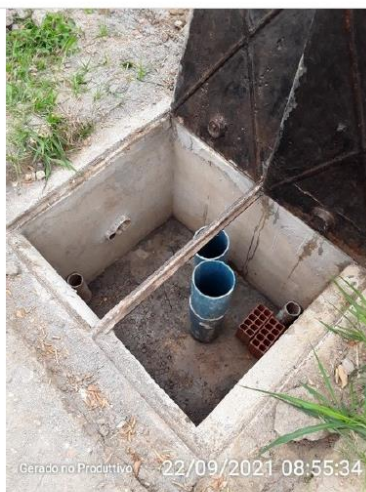
Poço Depósito de Resíduos
