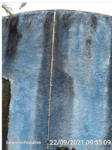
Medidor de nível do reservatório
