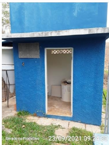
Depósito de produtos químicos
