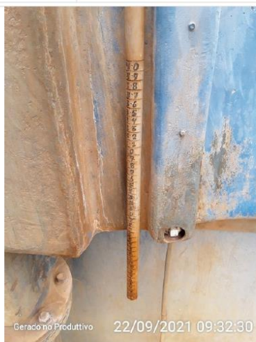
Règua utilizada para a medição de vazão na entrada da ETA
