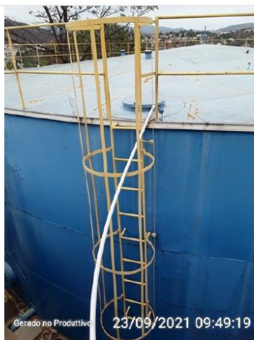
Escada para acesso a cobertura do reservatório
