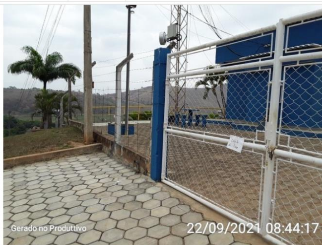
Cercamento no entorno da ETA
