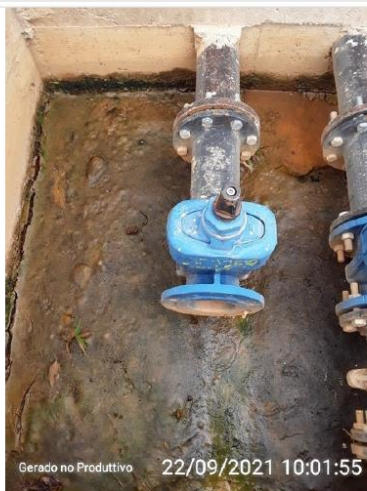
Tubo de descarga de fundo
