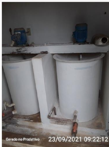
Misturadores mecanizados
