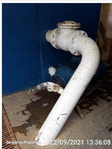
Torneira para coleta de água
