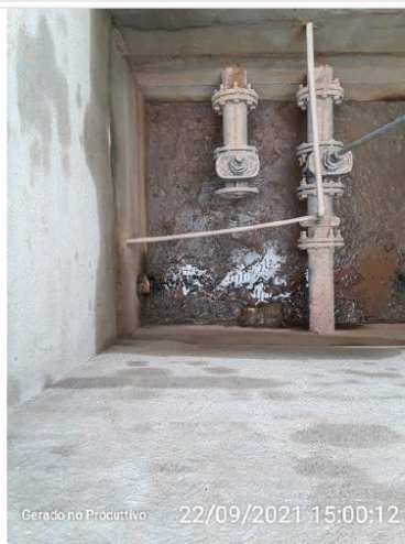
Tubo de descarga de fundo
