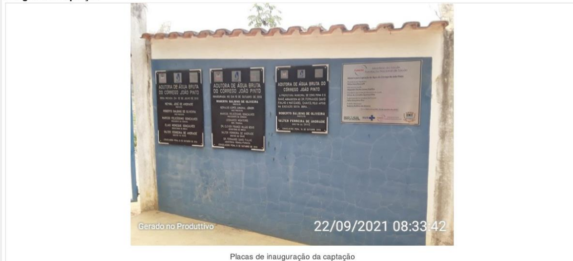
Placas de inauguração da captação
