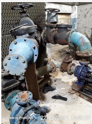
Piso da EEAT
