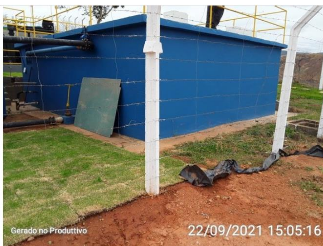
Reservatório ETA I
