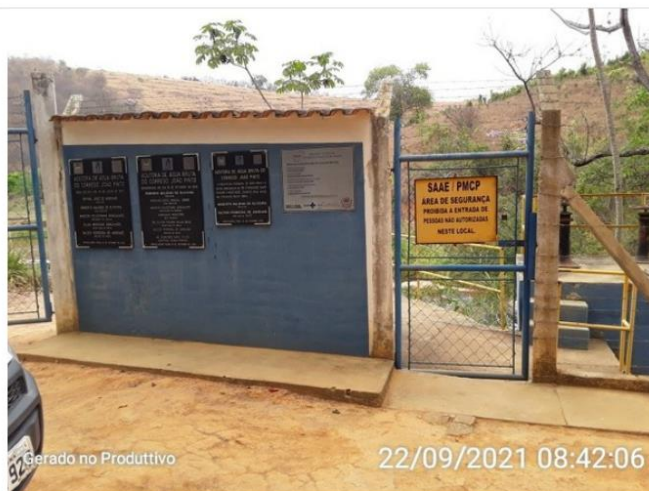
Acesso à Captação Córrego João Pinto
