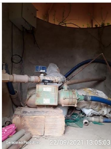
EEAB Captação Córrego da Penha Jusante
