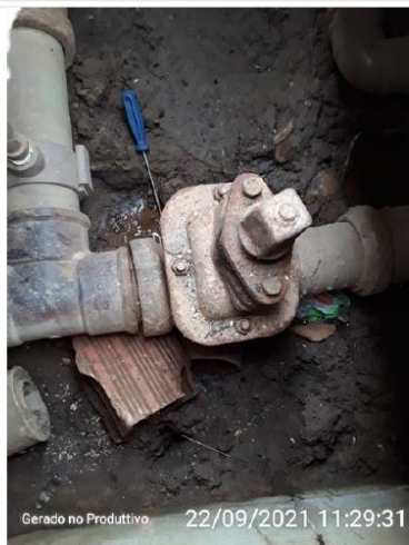
Válvula na saída do reservatório
