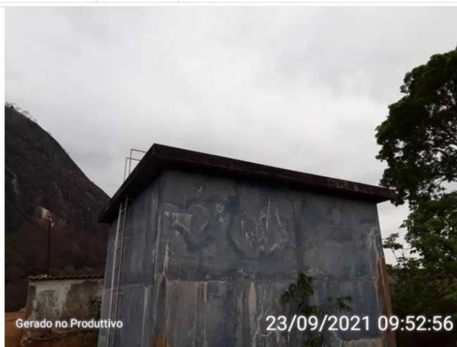
Cobertura do reservatório
