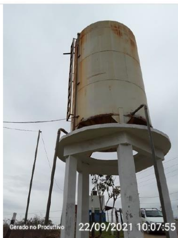
Escada do reservatório
