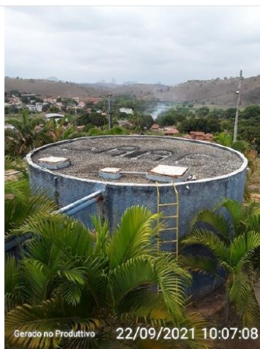
Reservatório ETA I
