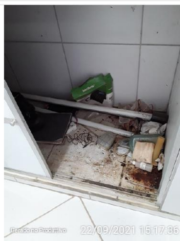
Armário sob a bancada do laboratório
