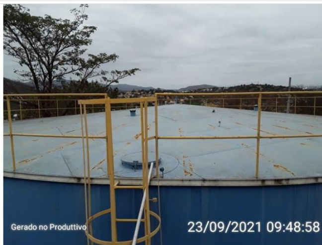
Cobertura do reservatório
