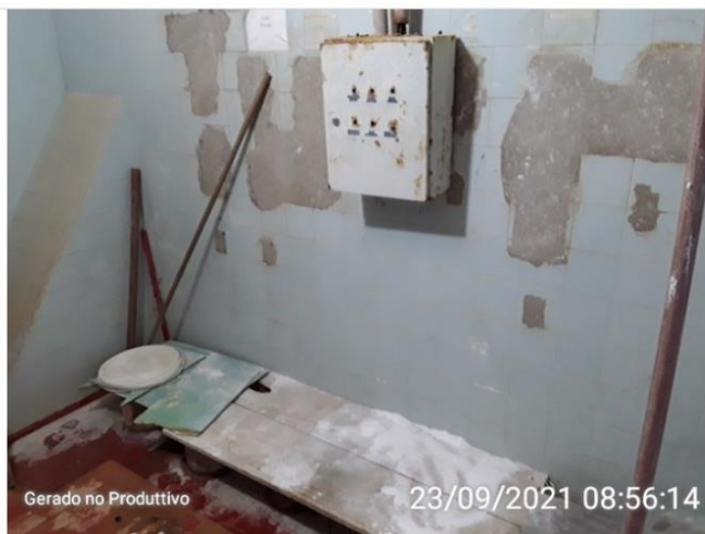
Sala de dosagem
