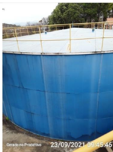
Reservatório área da ETA
