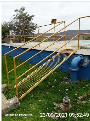
Escada de acesso a cobertura do reservatório
