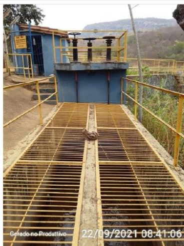
Existência de guarda-corpo na área de captação
