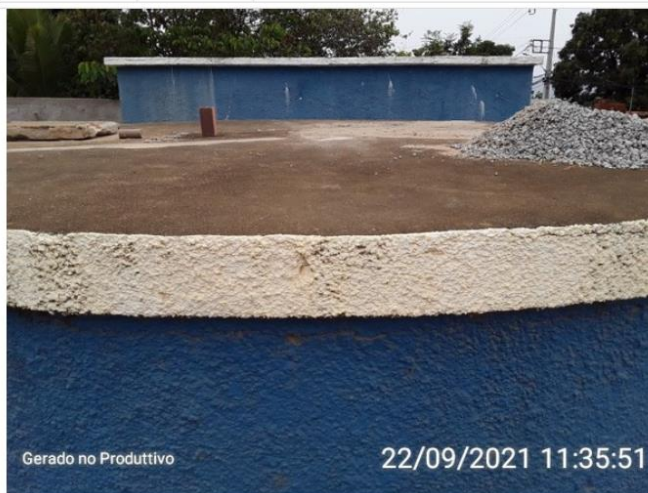
Cobertura do reservatório
