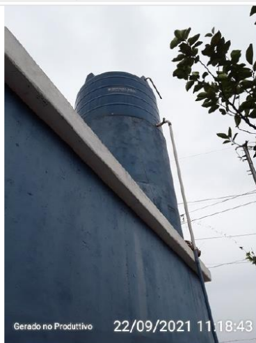
Ha um reservatório elevado sobre o reservatório principal
