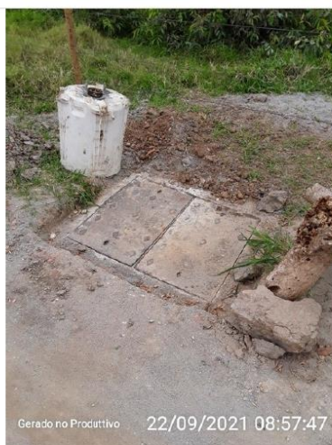
Poço Depósito de Resíduos
