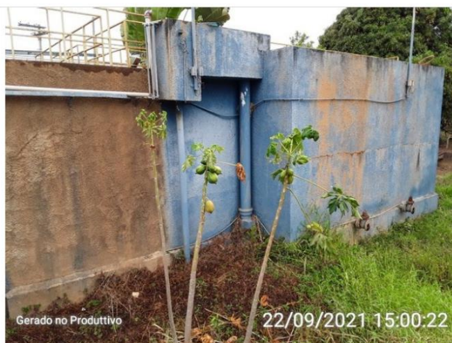
Lateral da ETA
