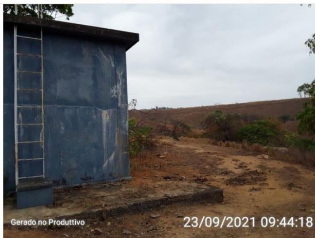
Entorno da área do reservatório
