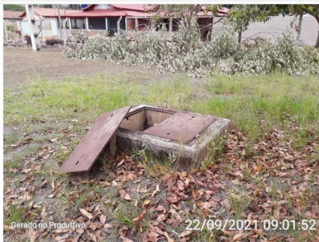
Estrutura de alvenaria que protege o poço.
