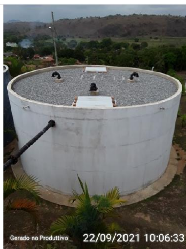
Reservatório ETA II
