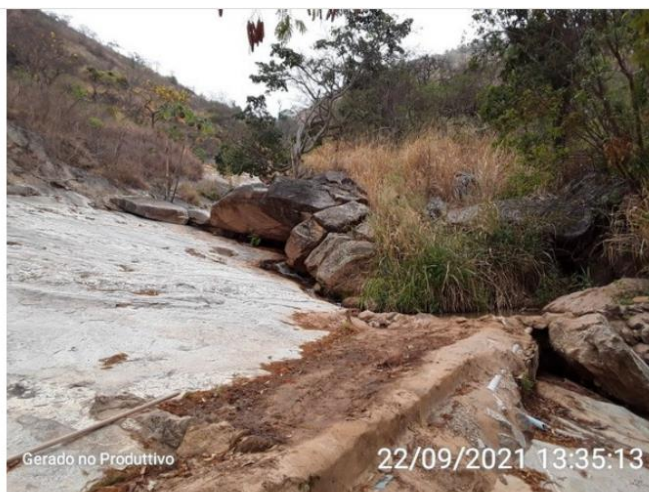
Captação Córrego da Penha Montante - Penha do Norte
