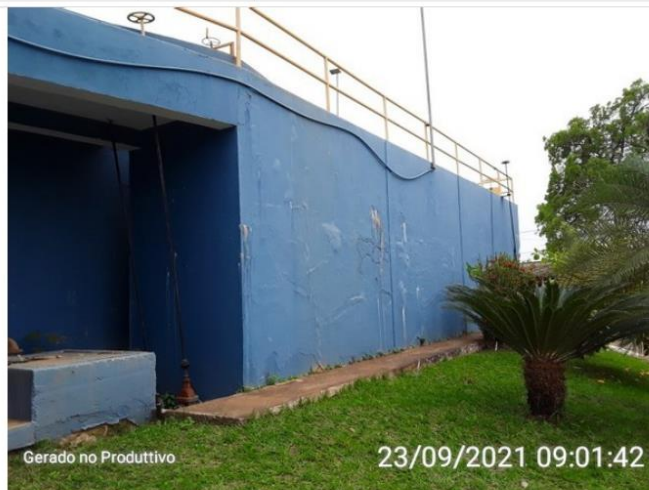
Lateral da ETA
