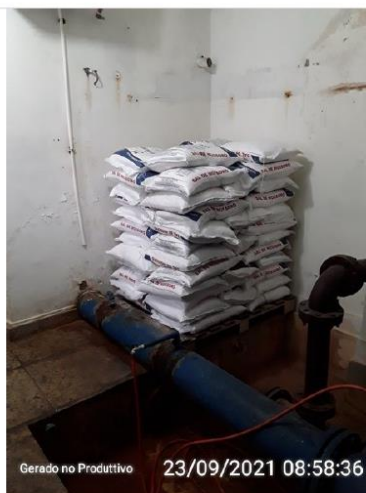
Área de armazenamento de produtos químicos
