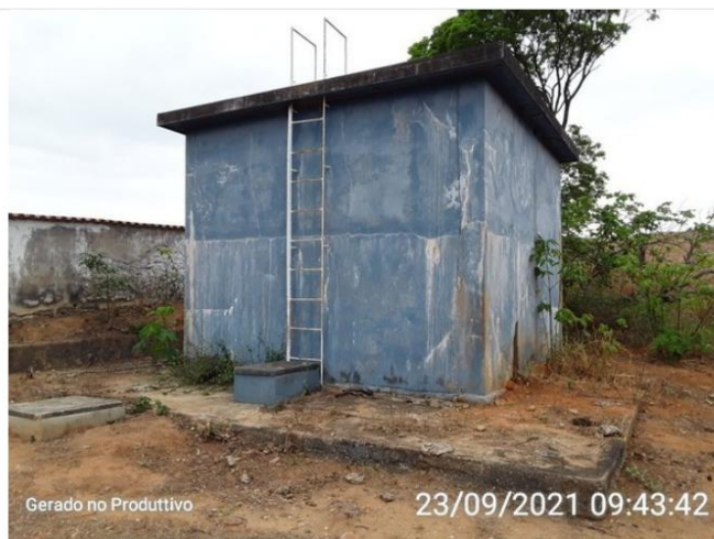
Reservatório Cuieté Velho
