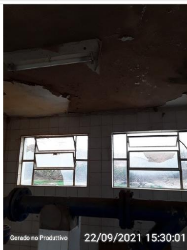
Teto da sala de bombas
