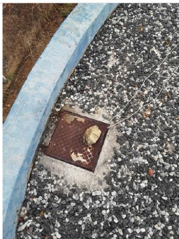
Tampa de inspeção
