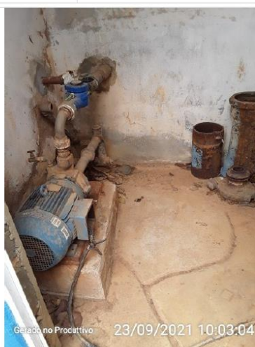
Piso da casa de bomba
