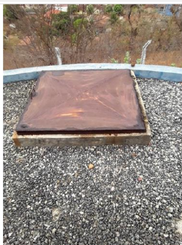
Tampa de inspeção
