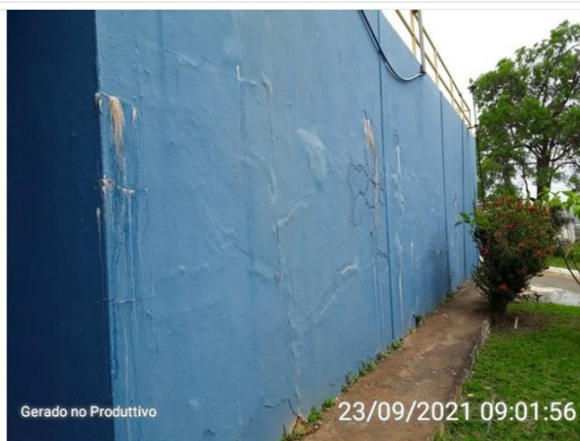
Lateral da ETA
