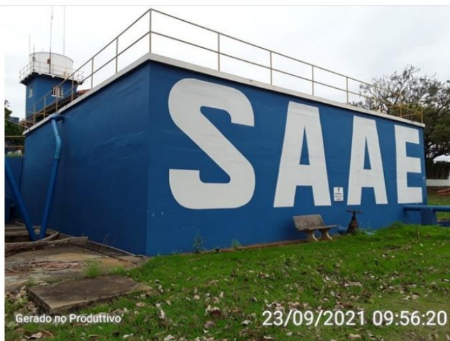
Reservatório retangular ETA
