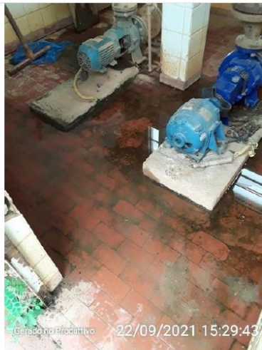
Piso da sala de bombas
