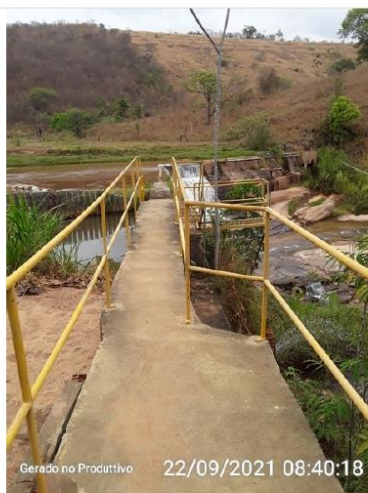
Existência de guarda-corpo na área de captação
