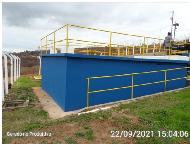
Reservatório ETA I
