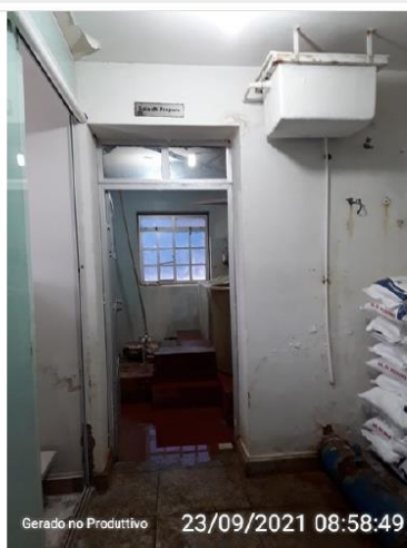
Entrada da sala de preparo
