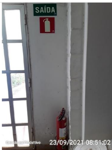
Extin tor de incêndio
