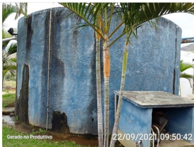
Reservatório ETA I
