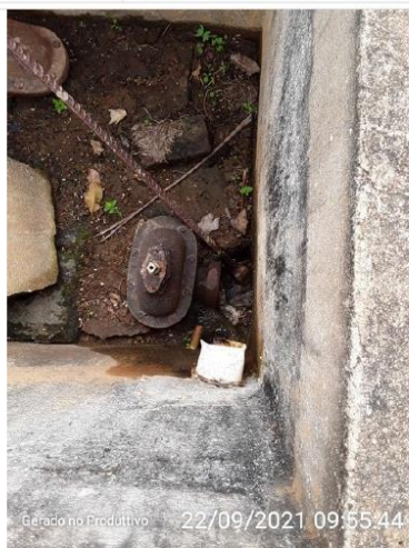
Tubo de descarga de fundo
