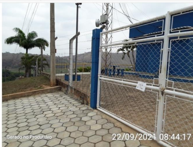
Cercamento no entorno da ETA
