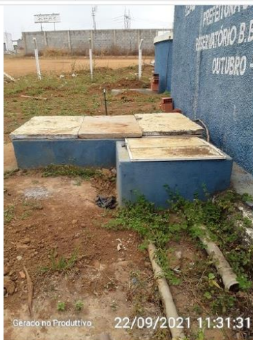
Caixa do tubo extravasor
