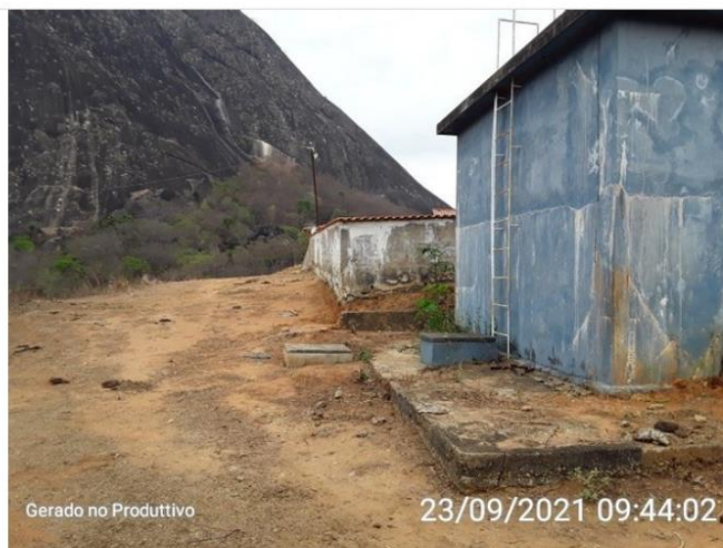
Reservatório Cuieté Velho
