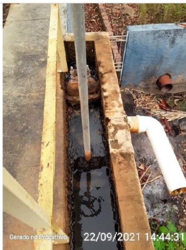
Calha dos decantadores
