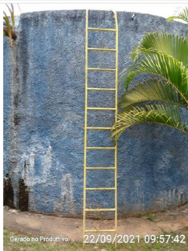
Escada de acesso
