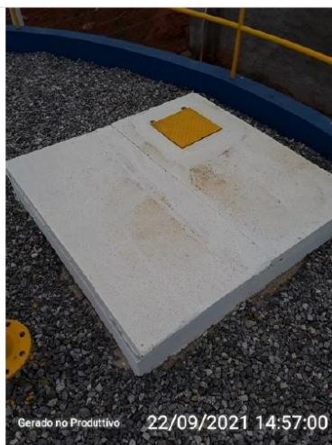
Tampa de inspeção do reservatório
