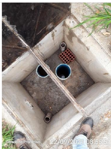
Poço Depósito de Resíduos
