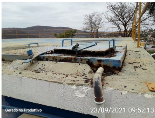
Tampa de inspeção
