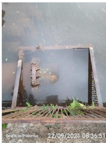
Grades e telas da captação
