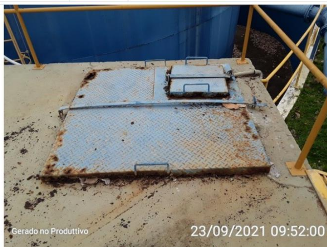
Tampa de inspeção
