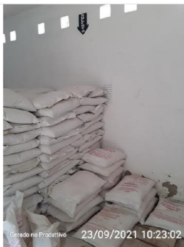
Depósito de armazenamento de produtos químicos
