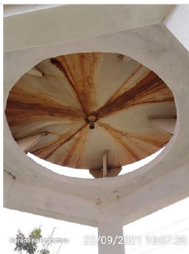
Descarga de fundo
