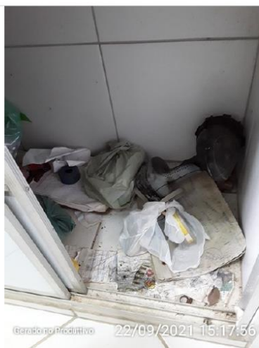
Armário sob a bancada do laboratório
