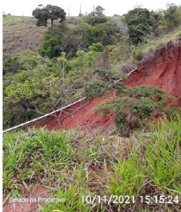
Deslizamento de terra ocorrido no entorno da ETA.
