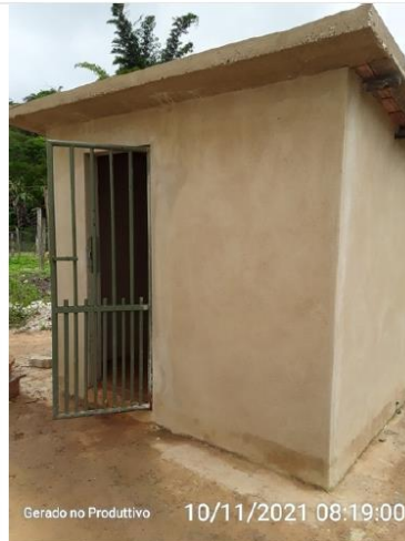
Área do poço artesiano
