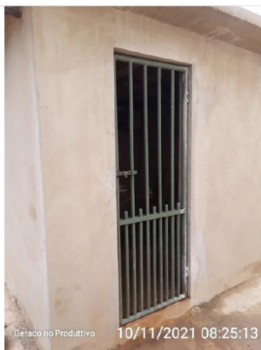
Portão de acesso a área do poço
