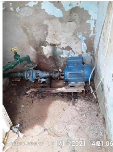
Conjunto motobomba sem base de apoio adequada e com o acoplamento sem proteção
