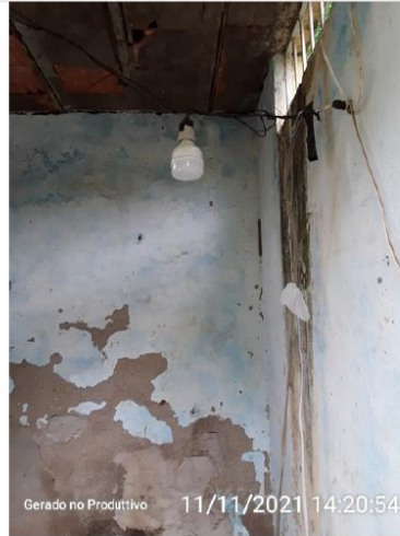
Acabamento nas paredes e fiação exposta
