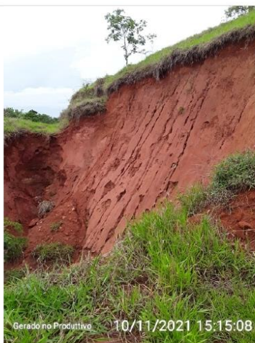
Deslizamento de terra ocorrido no entorno da ETA
