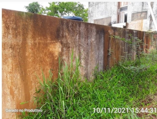
Lateral da ETA
