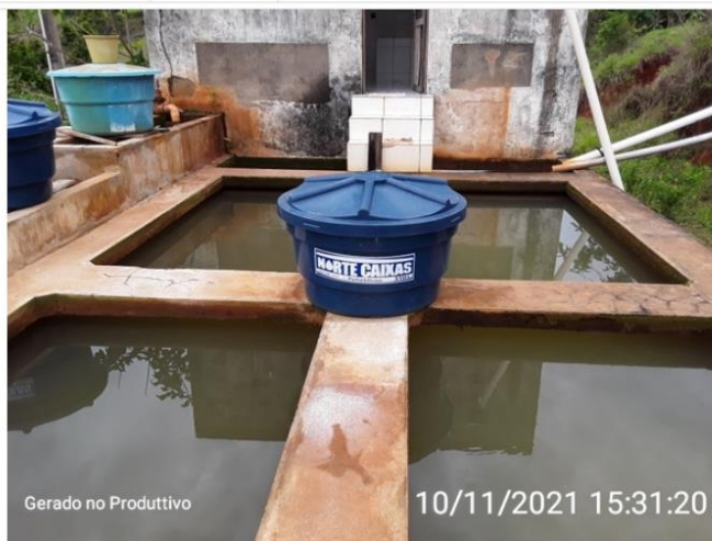
Área dos decantadores
