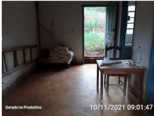
Depósito de produtos químicos
