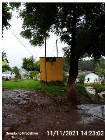
Estação elevatória Vila Formosa
