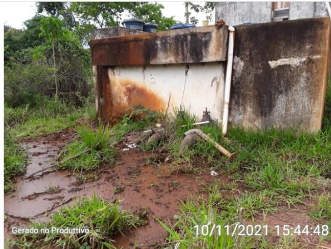
Lateral da ETA
