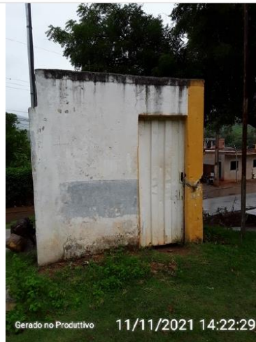
Estação elevatória Vila Formosa
