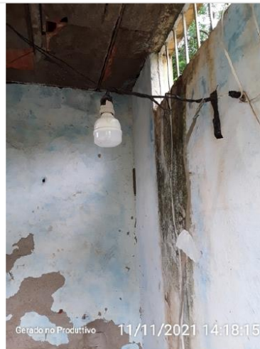
Iluminação da EEAT
