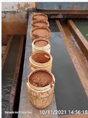
Lodo retirado dos decantadores
