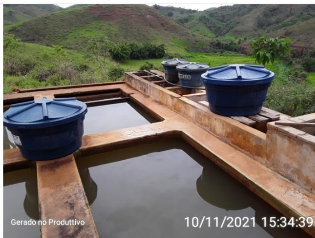
Área dos decantadores e floculadores
