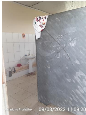
Banheiro utilizado como vestiário.
