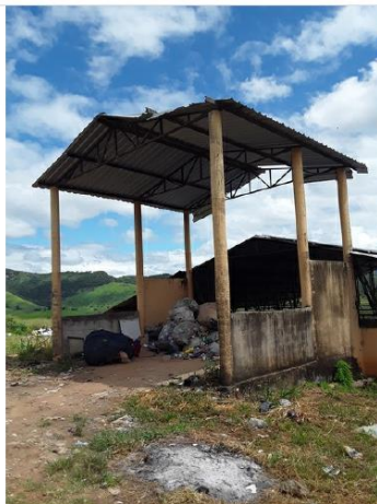
Altura do galpão de descarga dos resíduos sólidos.
