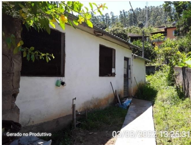
Parte externa da casa de bombas.
