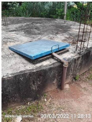
A tampa do local de inspeção
