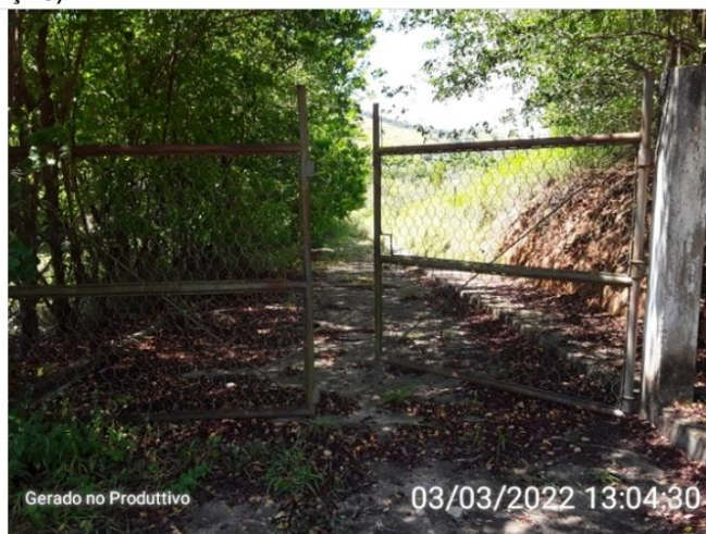
Portão de acesso da ETE.
