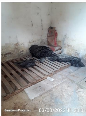
Forma de estocagem dos produtos químicos na ETA.
