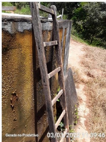
Escada de acesso a laje do reservatório.
