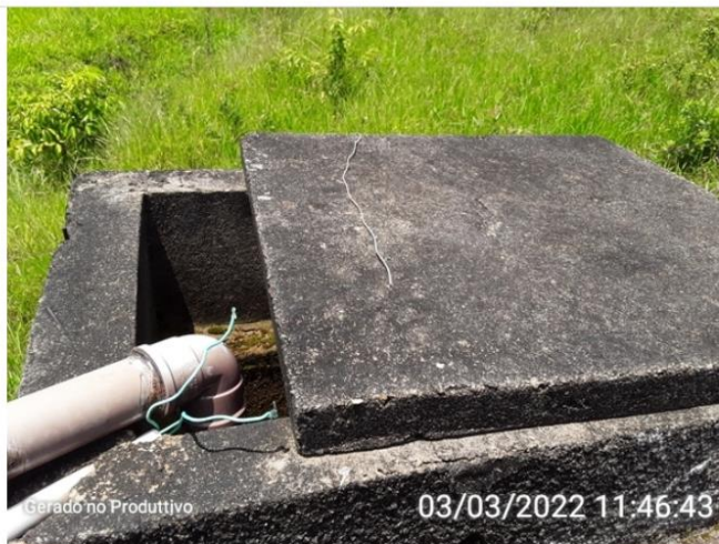
Tampa de inspeção do reservatório.
