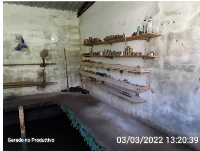
Equipamentos e materiais de manutenção onde chega a água captada.
