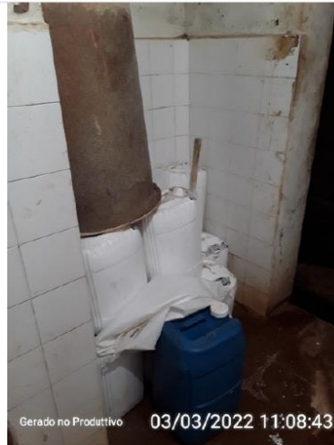
Armazenamento irregular dos produtos químicos.
