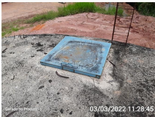
A tampa do local de inspeção
