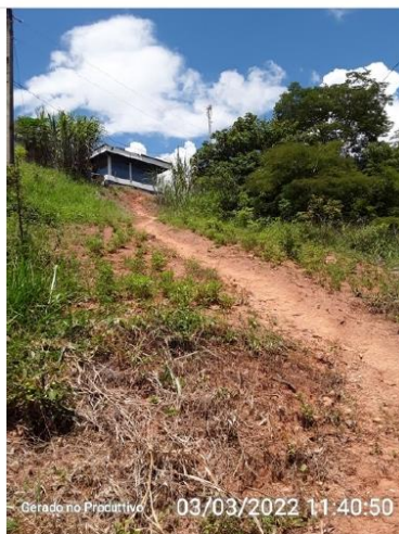
Parte inferior da ETA que dá acesso ao reservatório.
