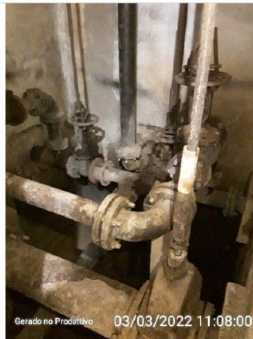
Vazamento no registro do filtro - ETA
