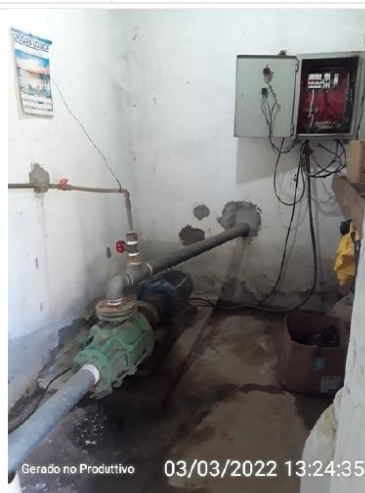
Espaço para manutenções.
