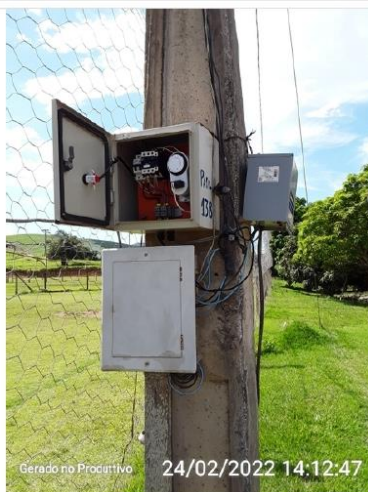
Quadros e cabos elétricos expostos
