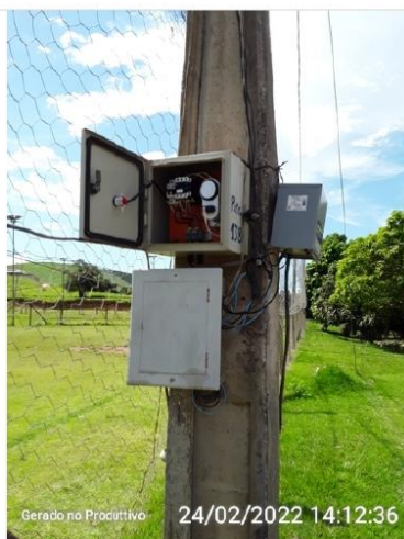
Quadros e cabos elétricos expostos
