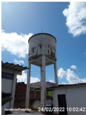
Reservatório elevado ETA
