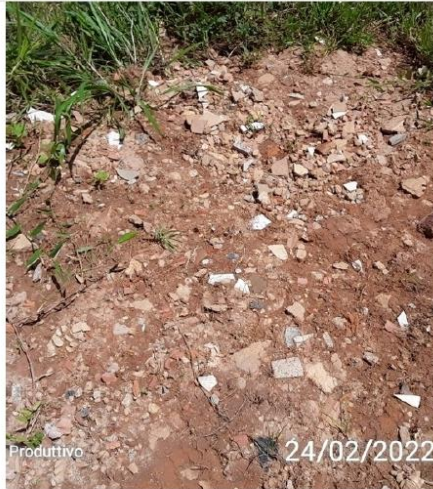
Reutilização de resíduos de construção civil para firmar as margens do local de barramento.
