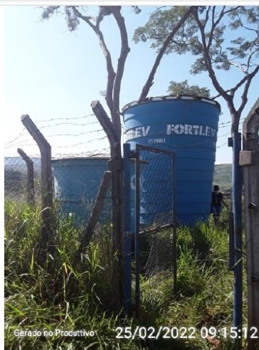
Cercamento do reservatório
