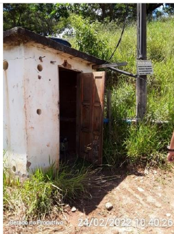
Local da Casa de Bombas.
