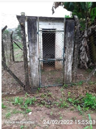
Portão de acesso
