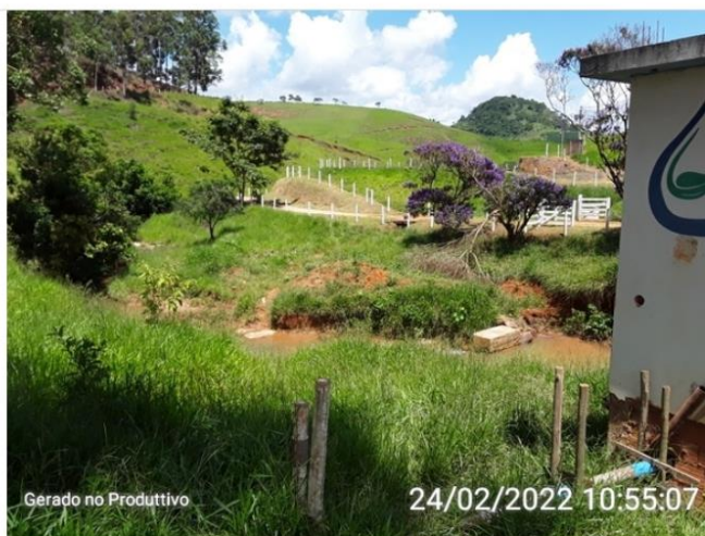
Proximidades do Reservatório sem cercamento
