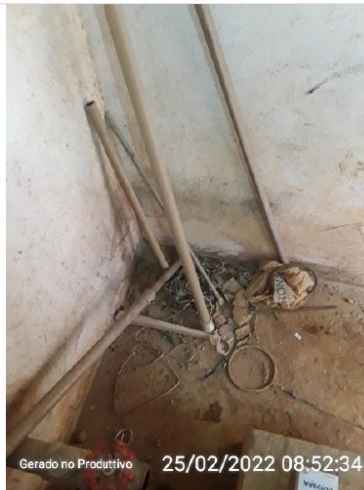
Restos de resíduos de construção
