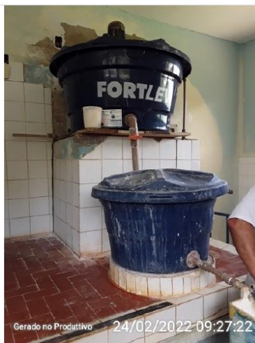
Processo manual na Casa de Químicos.
