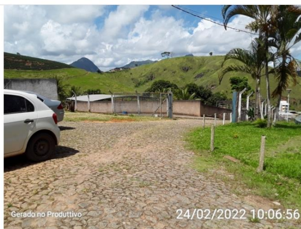
Entrada de acesso a ETA - Lajinha
