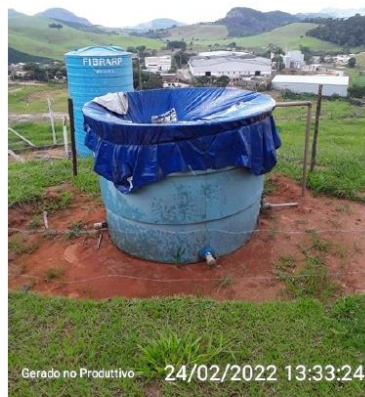
Cobertura do reservatório
