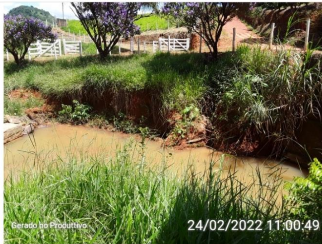
Processos erosivos em taludes
