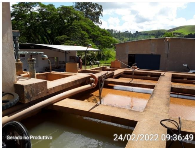
Iluminação da ETA.
