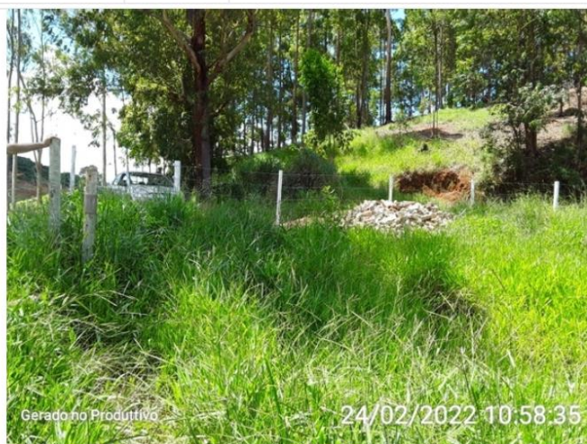
Cercamento da propriedade ao redor da captação.
