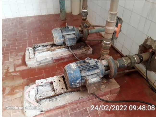
Estrutura da casa de bombas
