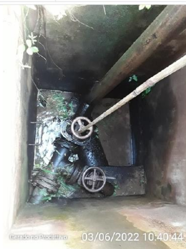
Descarga de fundo
