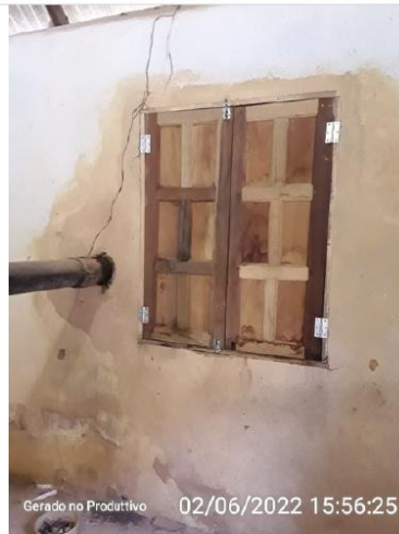
Janela da casa de bomba
