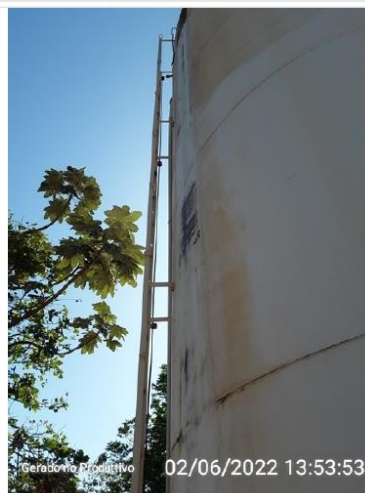
Escada de acesso a tampa de inspeção do reservatório
