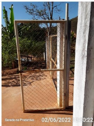
Portão de acesso a área do reservatório
