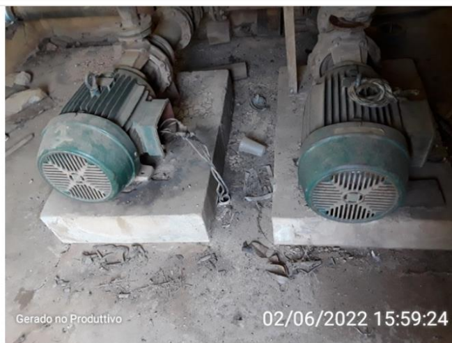
Piso da casa de bomba
