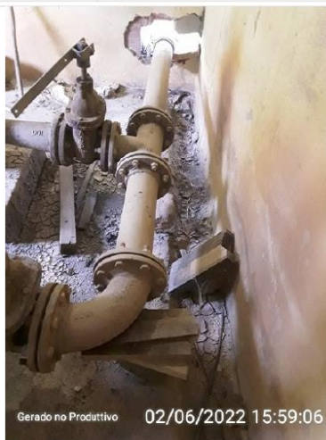
Piso da casa de bomba
