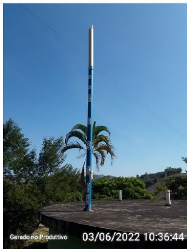
Dispositivo indicador de nível
