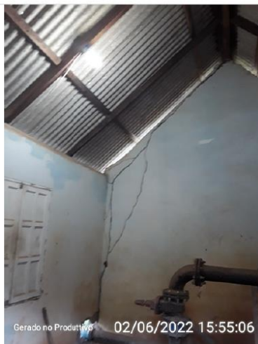
Iluminação da casa de bomba
