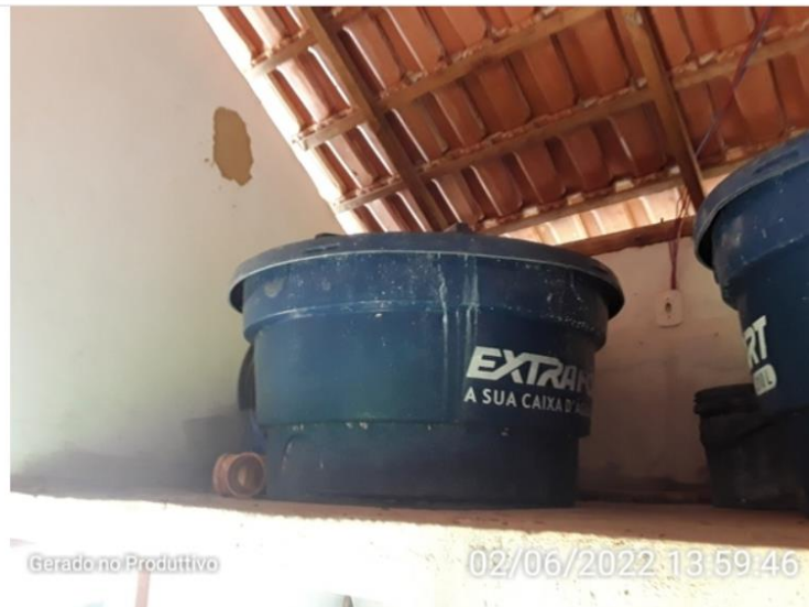
Reservatórios de produtos químicos
