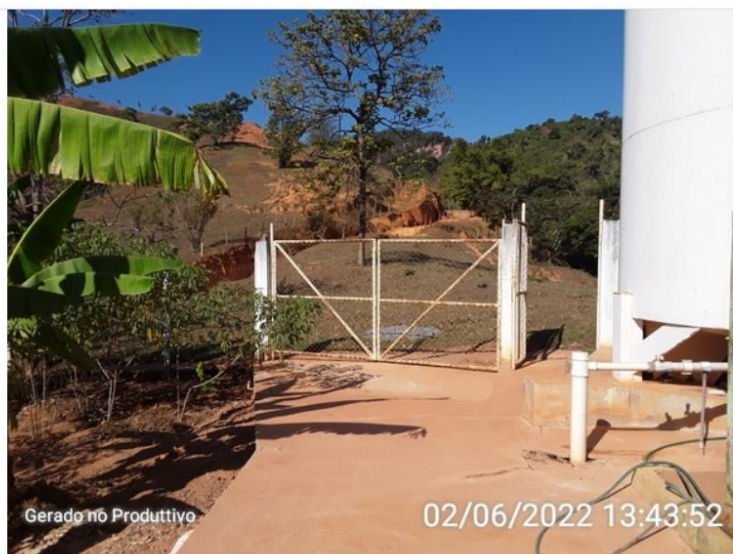
Portão de acesso da ETA
