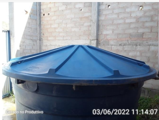
Tampa de inspeção
