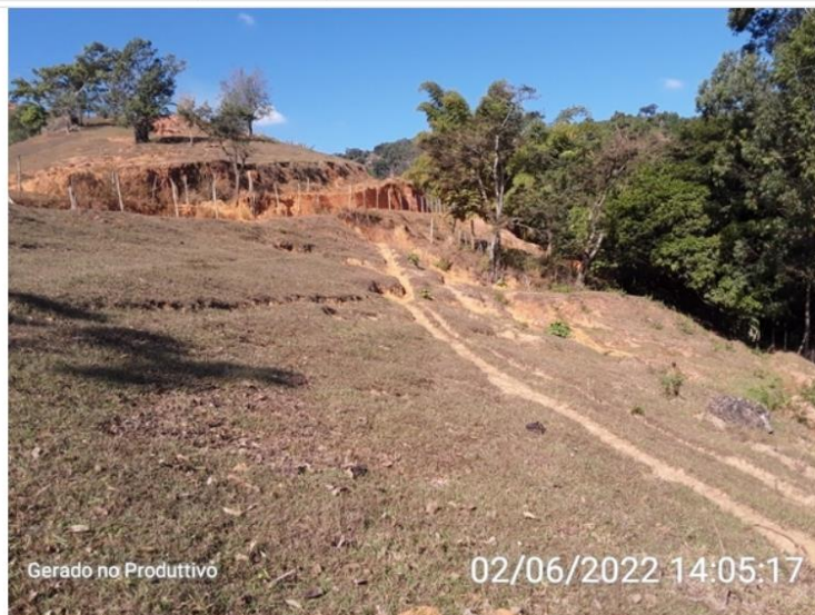
Acesso a área da ETA
