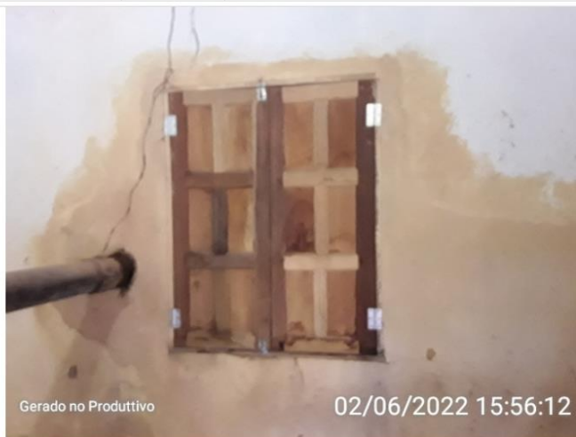
Janela da casa de bomba
