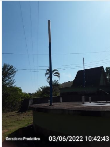
Dispositivo indicador de nível de água
