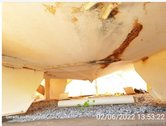
Descarga de fundo
