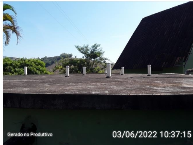
Cobertura do reservatório
