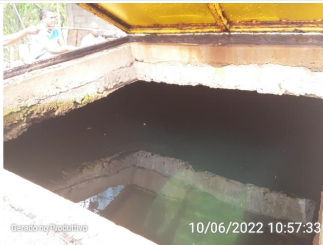
Abertura de inspeção do reservatório
