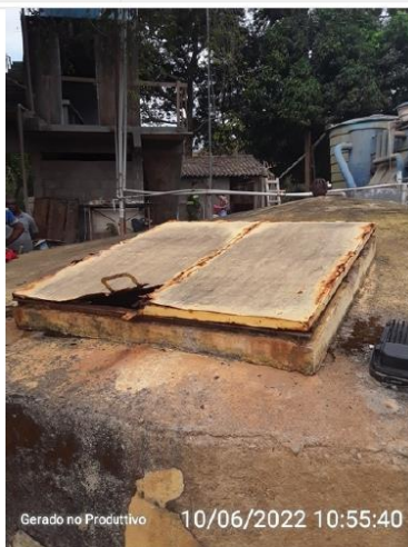
Tampa de inspeção
