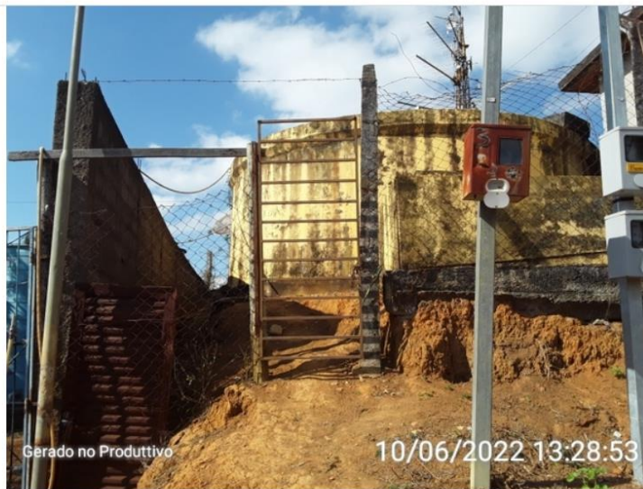
Cercamento do reservatório
