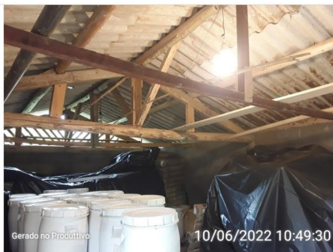
Telhado do depósito de produtos químicos
