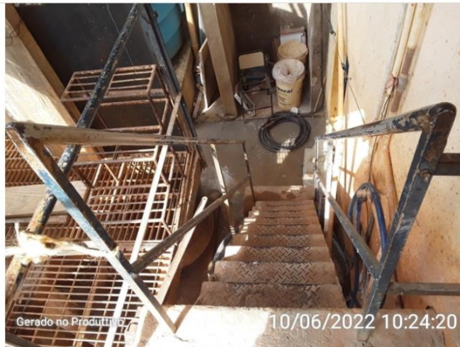
Escada de acesso a ETA
