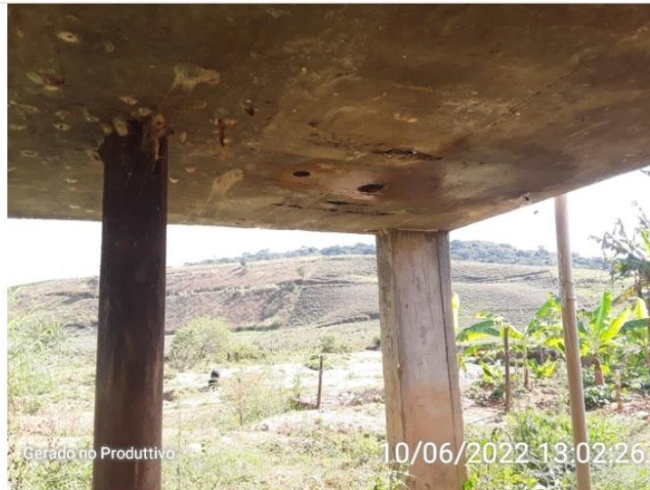
Laje da estrutura que abriga o painel de controle da captação
