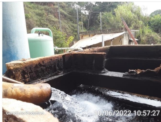
Caixa de passagem
