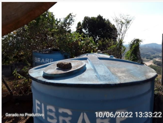
Tampa de inspeção
