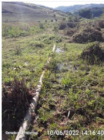
Adutora de água bruta
