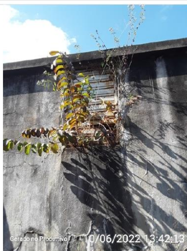
Tampa de inspeção
