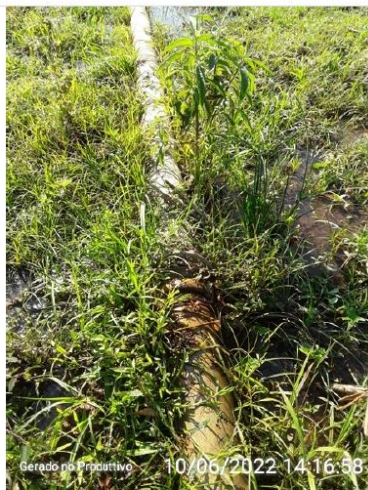
Adutora de água bruta
