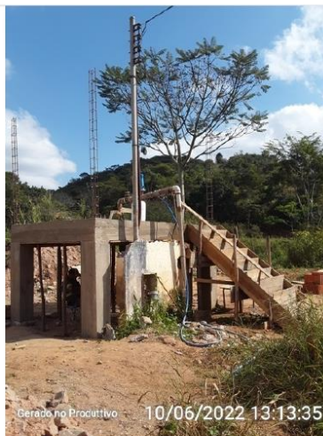
Área da captação
