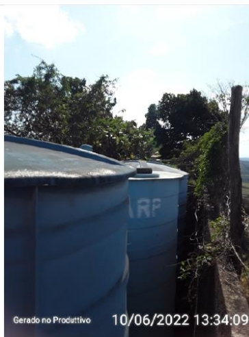
Tampa de inspeção
