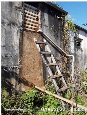
Escada para acesso a tampa de inspeção
