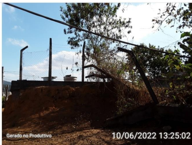
Cercamento da área do reservatório
