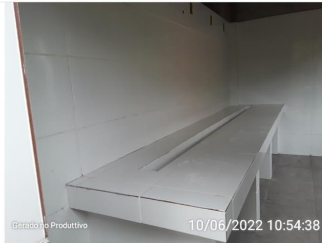
Local onde será casa de químicos
