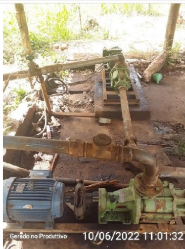
Piso da área dos conjuntos motobombas
