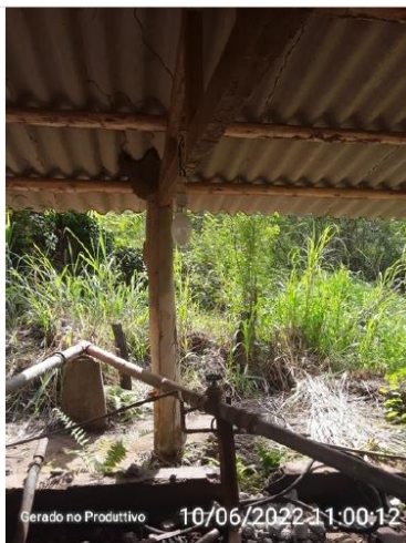
Iluminação para trabalhos noturnos
