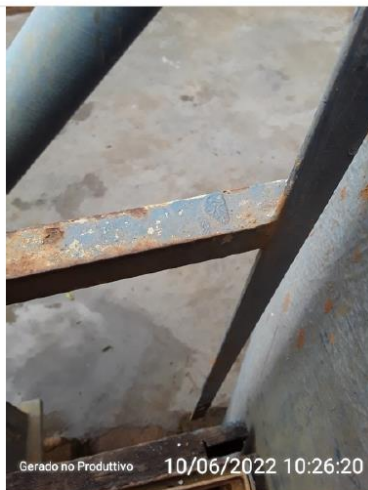
Detalhe do guarda - corpo da ETA
