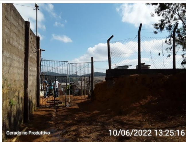
Cercamento da área do reservatório
