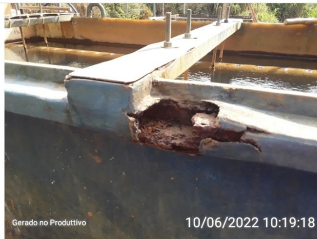
Estrutura da ETA
