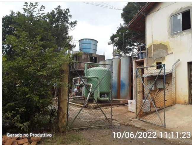
Portão de acesso a área da ETA
