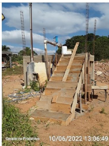
Área da captação
