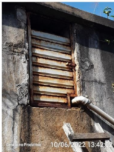
Tampa de inspeção
