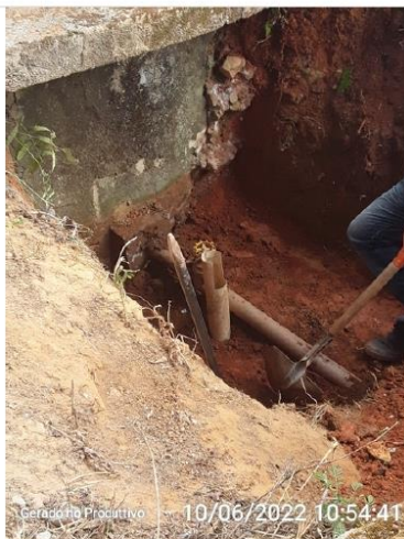
Tubo de descarga de fundo
