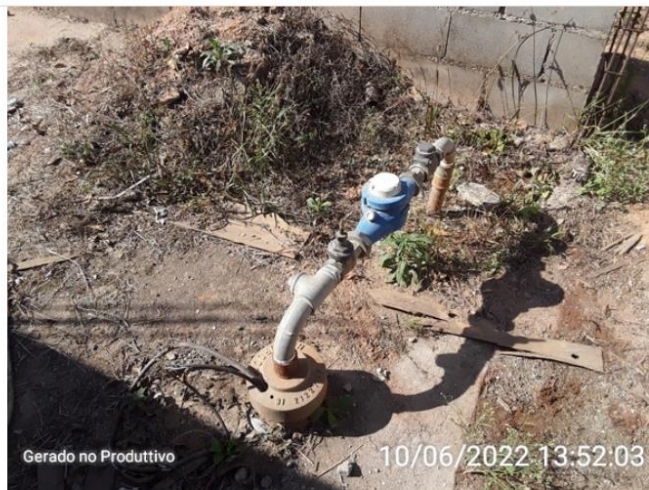
Laje de proteção
