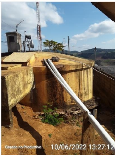
Reservatório Carlos Cardoso
