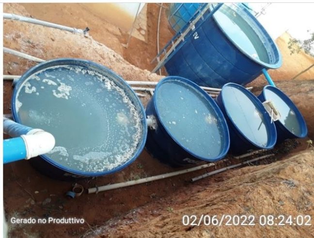
Floculadores em bom estado de conservação.
