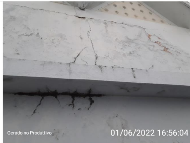
Estrutura do reservatório
