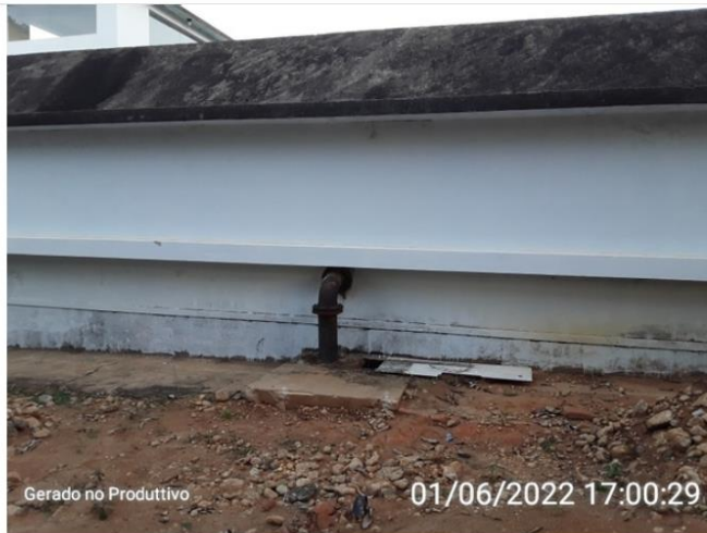
Tubo e caixa de descarga de fundo.
