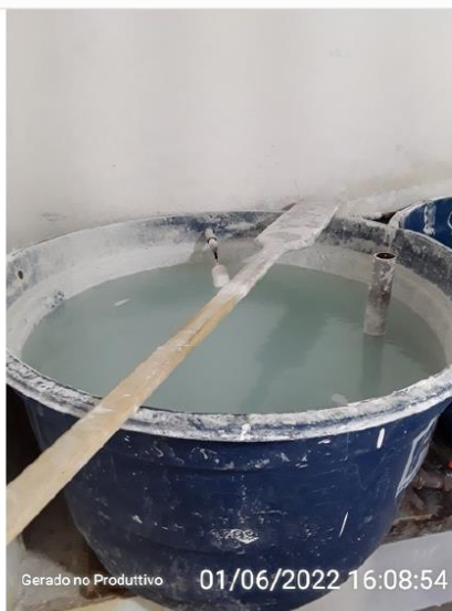
A mistura do cal é feita de forma manual.
