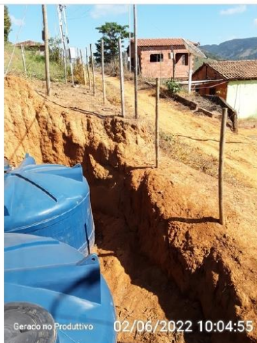
Cercamento dos reservatórios.
