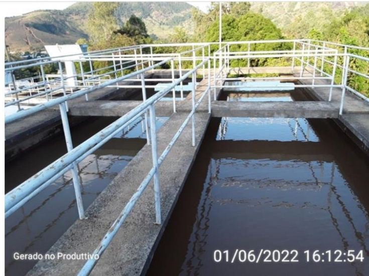
Decantadores do sistema retangular.
