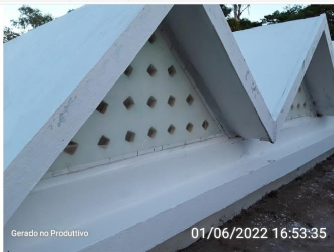
Estruturas de ventilação do reservatório com telas.
