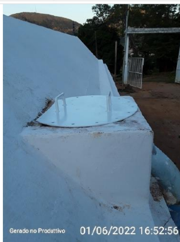
Tampa de inspeção em boas condições de uso.
