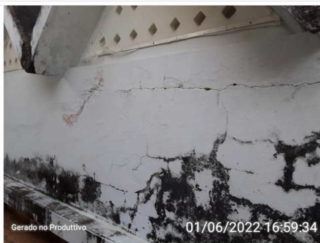
Estrutura do reservatório
