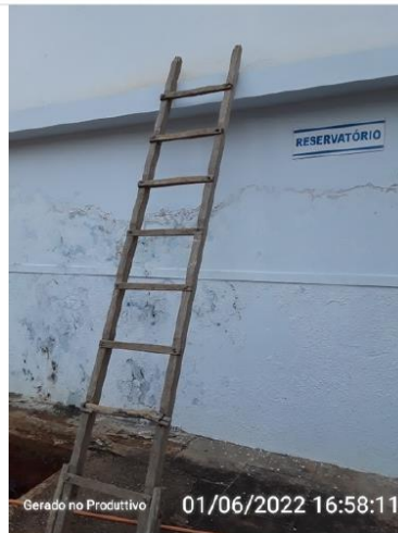
Escada usada para acesso a parte superior do reservatório.
