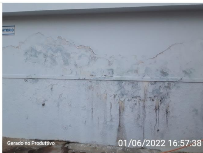
Estrutura do reservatório
