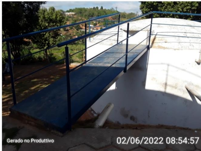
Rampa de acesso aos reservatório.
