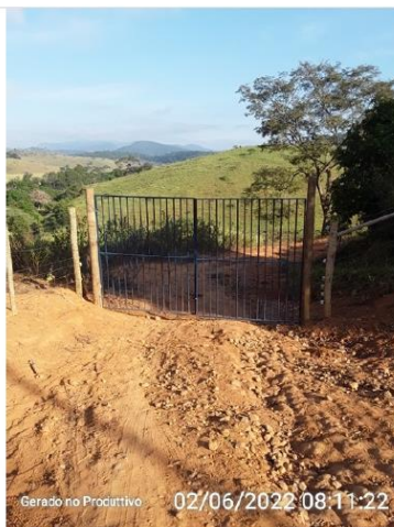
Portão de acesso a ETA.
