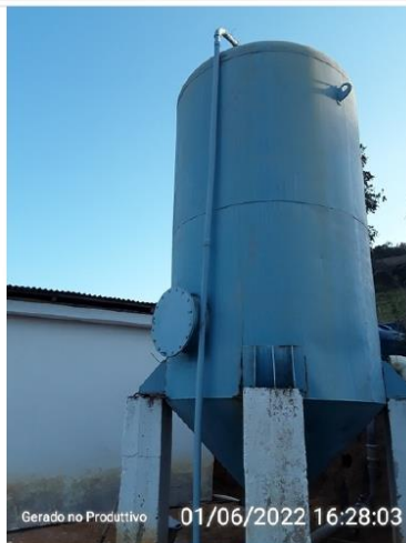
Tubo extravasor do reservatório elevado.
