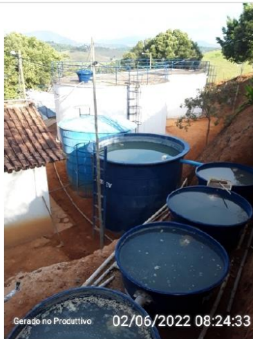
Decantadores em bom estado de conservação.
