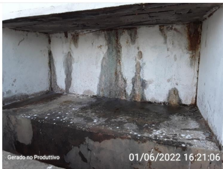
Infiltrações nas estruturas dos floculadores e decantadores do sistema circular da ETA.
