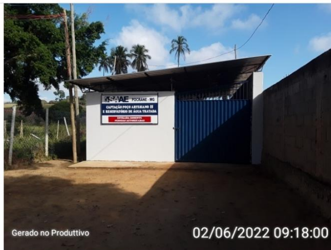
Área da EEAT e Reservatório
