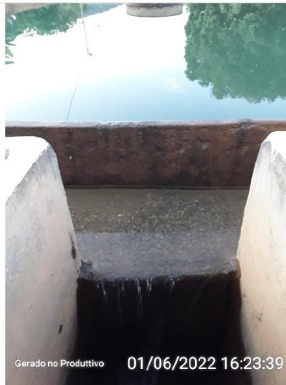
Passagem da água decantada para o tanque de contato.
