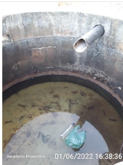
Passagem da água decantada para o tanque de contato.
