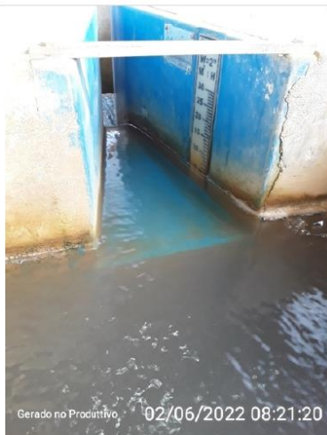
Régua de medição em bom estado de conservação.
