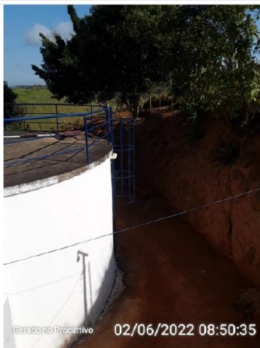
Tubo extravasor próximo a escada de acesso.
