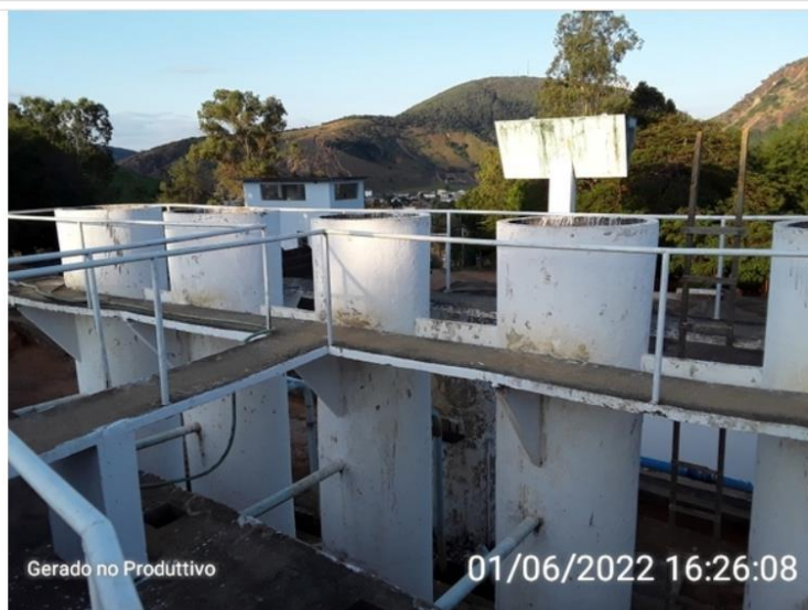
Infiltrações nas estruturas dos floculadores e decantadores do sistema circular da ETA.
