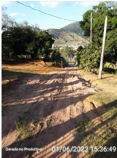
Acesso até a ETA em bom estado de conservação.
