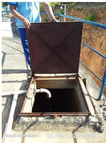
Estrutura da tampa de inspeção.
