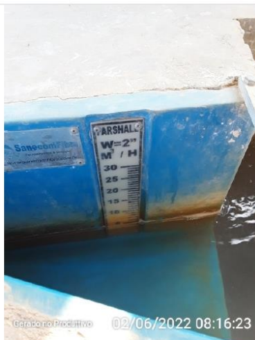
Régua de medição na calha parshal.
