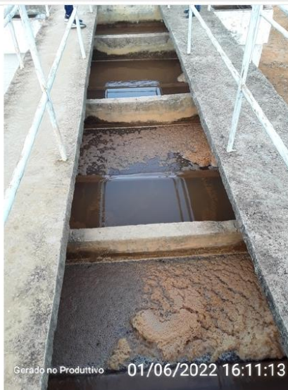
Formação de Flocos no sistema retangular da ETA.
