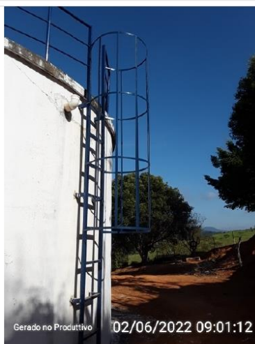
Escada de acesso ao compartimento 1 do reservatório.
