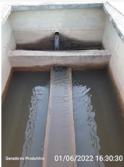
Filtro 2 do sistema retangular em boa condições.
