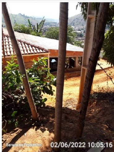
Entrada de acesso ao reservatório.
