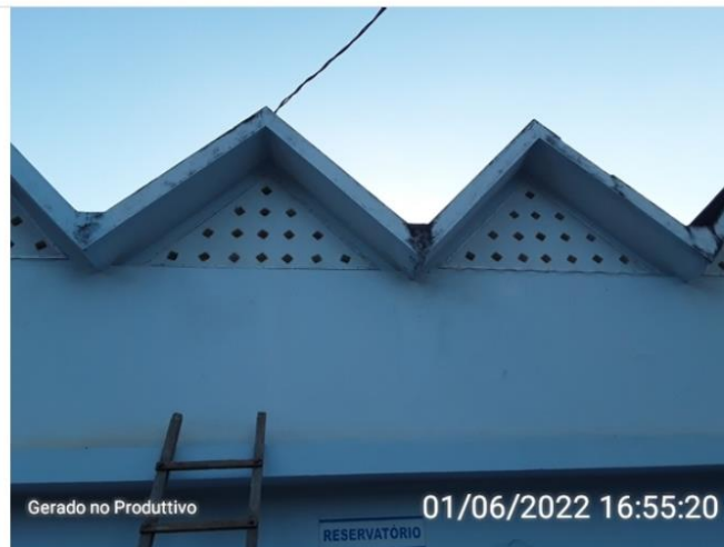
Aberturas de ventilação
