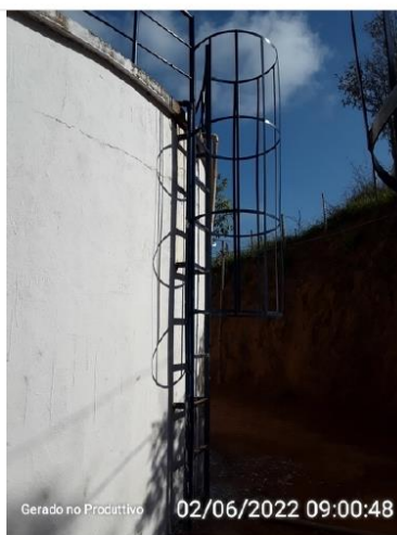
Escada de acesso ao compartimento 2 do reservatório.
