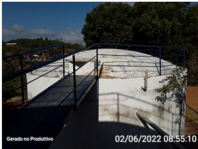
Reservatório com guarda-corpos.
