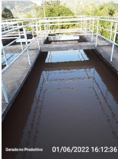
Decantador do sistema retangular.
