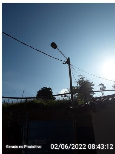
Poste com iluminação noturna.
