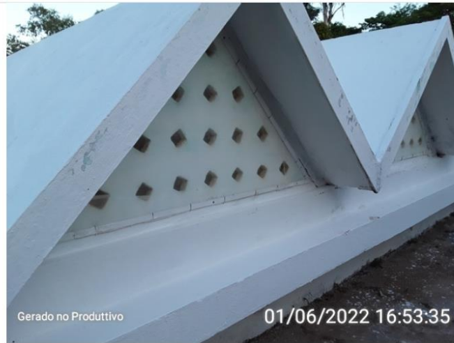
Estruturas de ventilação do reservatório com telas.
