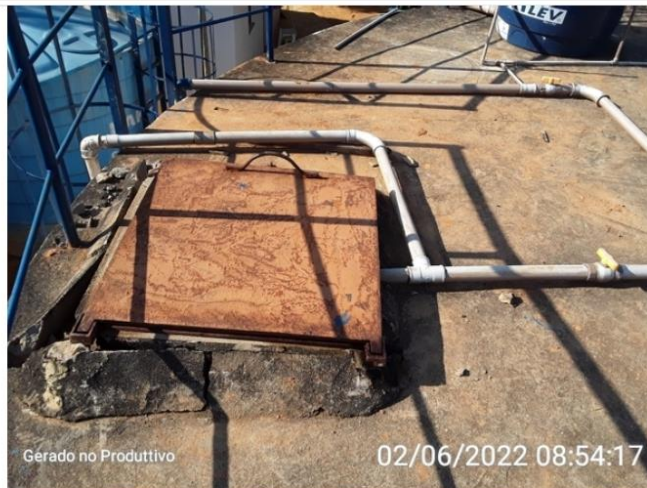
Tampa de inspeção do reservatório.
