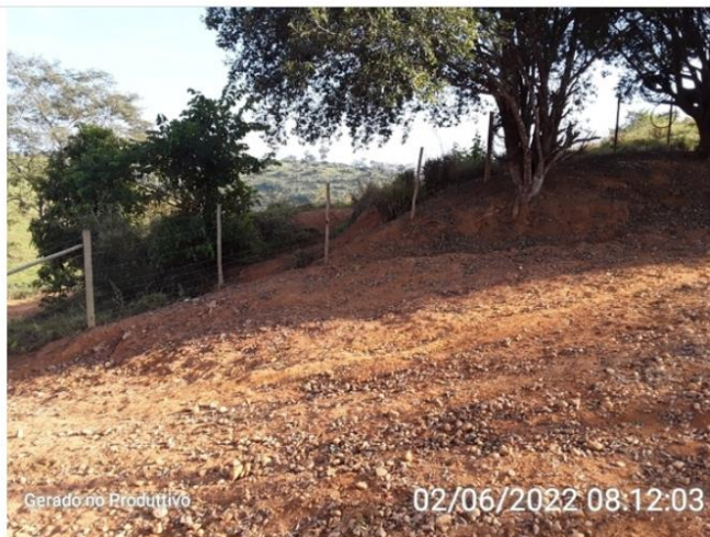
Cercamento da ETA.
