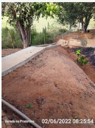
Construção de escada de acesso até o local da chegada da água bruta.
