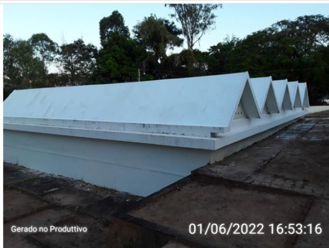
Piso impermeável que facilita o escoamento das águas pluviais.
