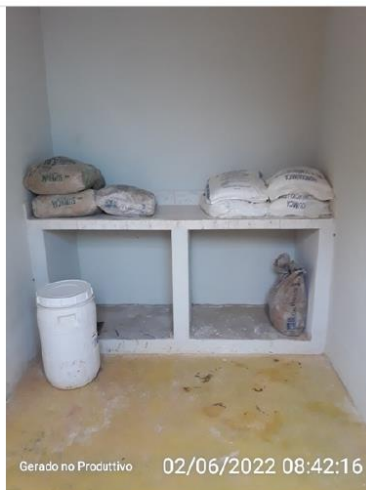
Depósito de produtos químicos em bom estado de conservação e limpeza.
