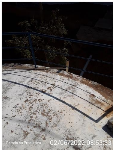
Local de ventilação do reservatório.
