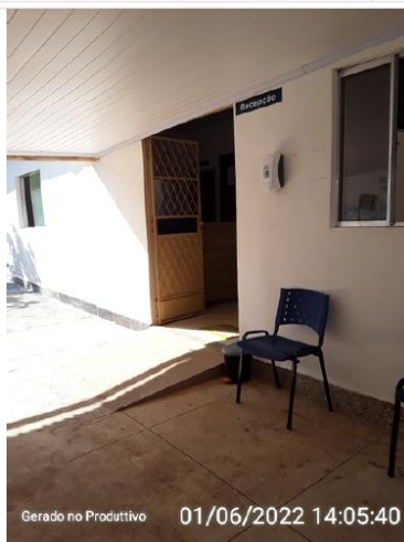
Acessibilidade para atendimento aos usuários.
