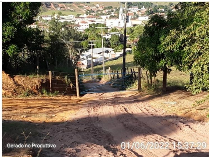
Portão de acesso e cercamento da ETA.
