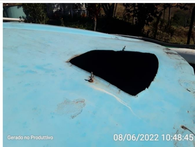
Tampa de inspeção reservatório A.
