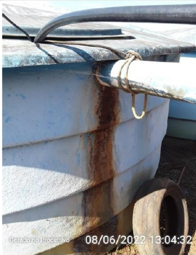
Encaixe da Tubulação com vazamento.
