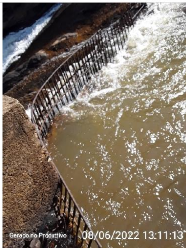
Sistema de gradeamento
