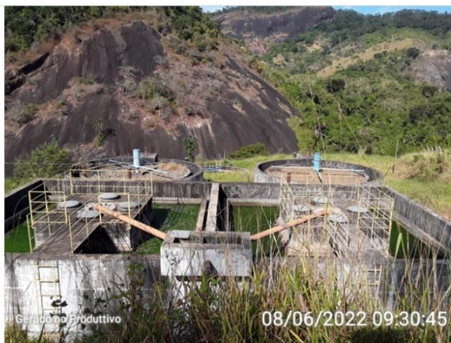
Reator anaeróbio de fluxo ascendente
