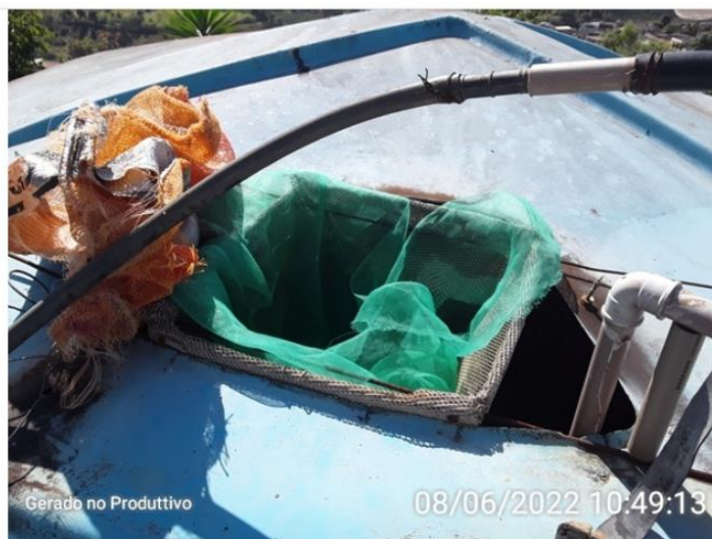
Tampa de inspeção reservatório C.
