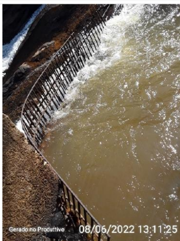
Sistema de gradeamento
