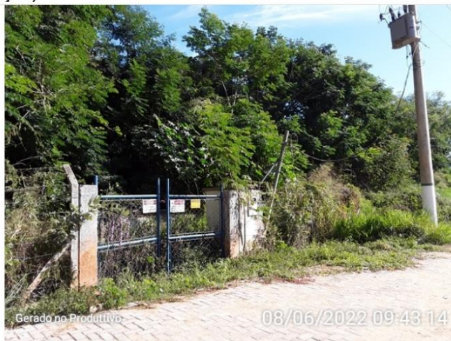
Área da estação elevatória de esgoto
