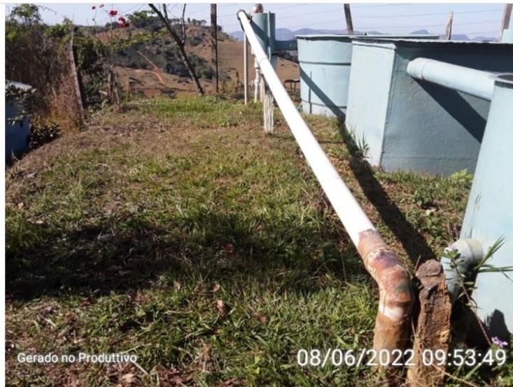
Piso gramado na ETA.
