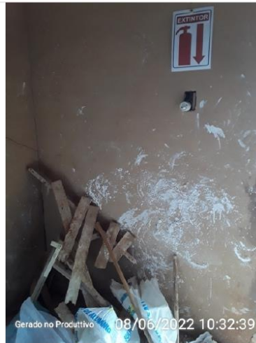
Depósito de produtos químicos
