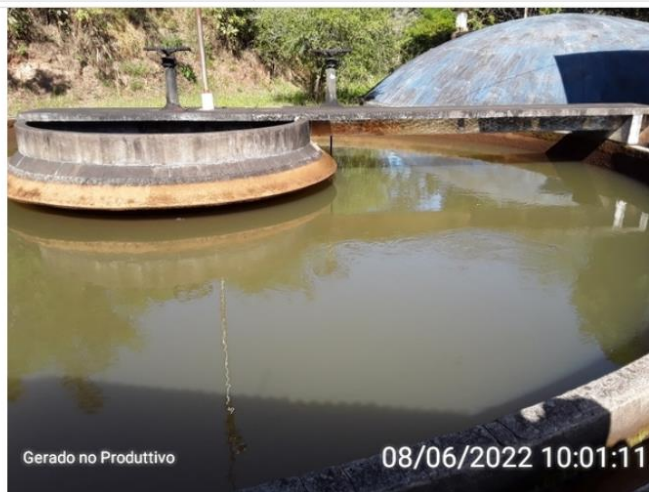
Decantador antigo, usado atualmente como reservatório de água bruta
