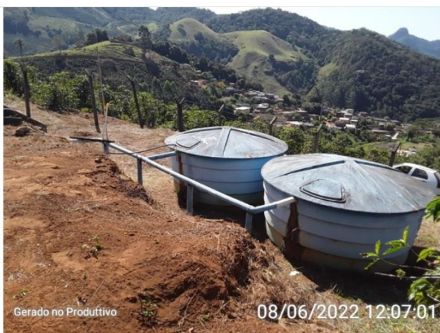
Vista Superior Reservatórios da ETA.
