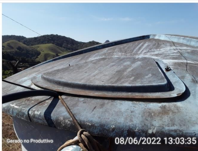
Acesso a tampa de inspeção do reservatório.
