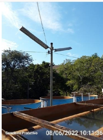
Sistema de iluminação
