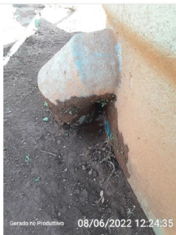
Vazamento na estrutura dos decantadores.
