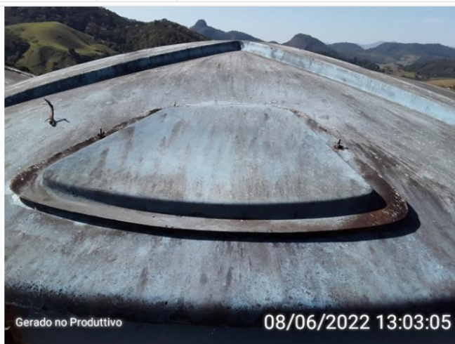
Tampa de inspeção.
