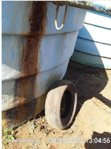
O operador utiliza o pneu para acessar a parte superior dos reservatórios que estão apoiados.
