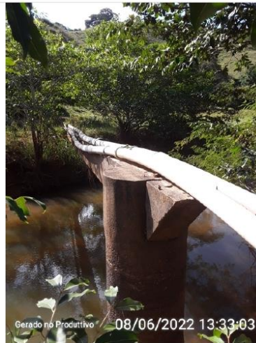
Trecho de travessia da adutora
