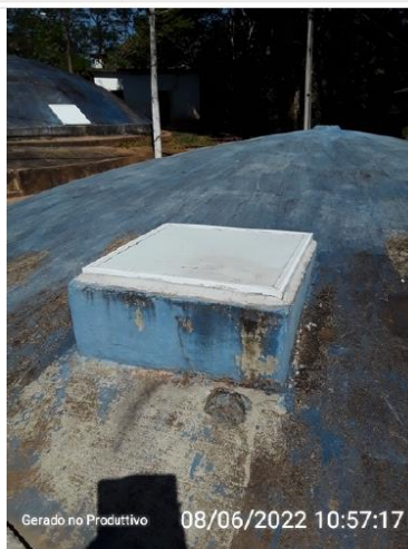
Tampa de inspeção
