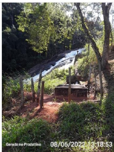
Área da captação
