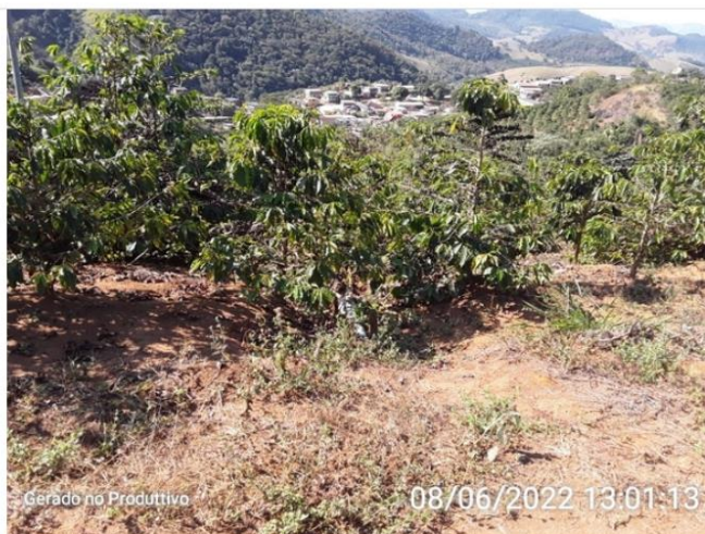
Válvula de saída fica fora da ETA, próximo ao cafezal.
