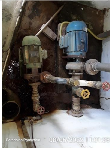
Piso da casa de bombas
