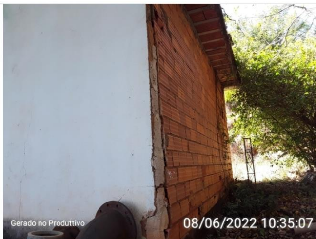
Depósito de produtos químicos
