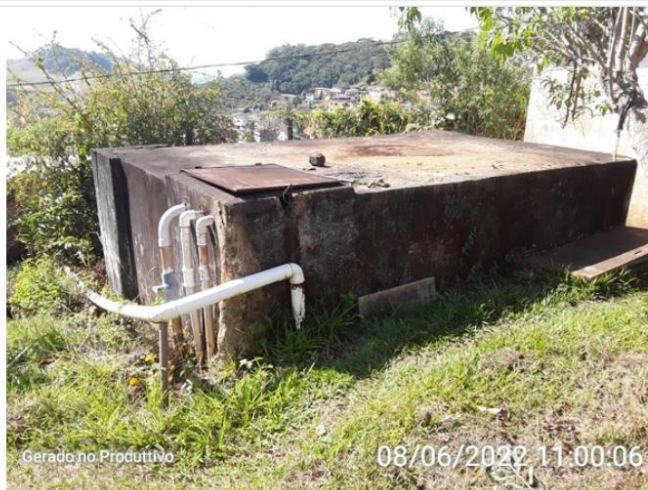
Reservatório de alvenaria em desuso.
