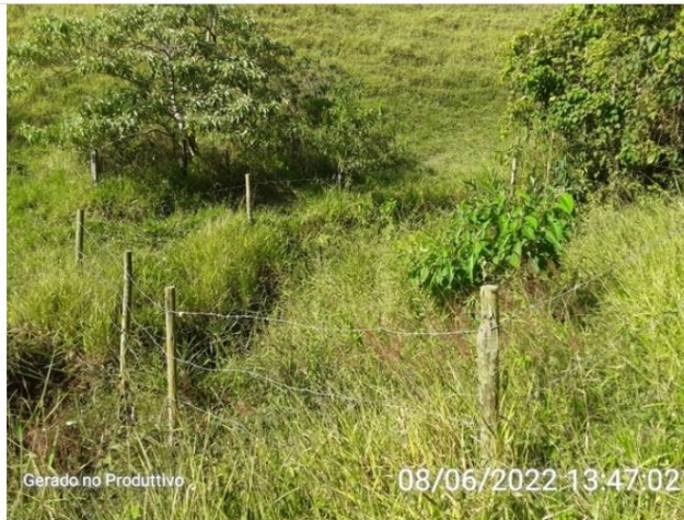
Cercamento do local de captação.
