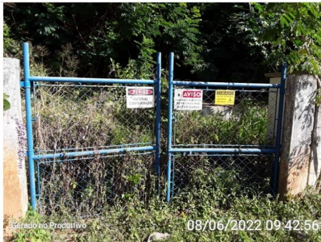
Área da estação elevatória de esgoto
