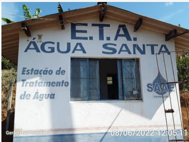
Identificação na estrutura da ETA.
