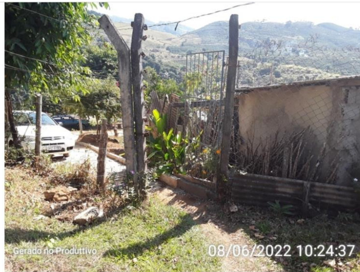
Portão de acesso da ETA.
