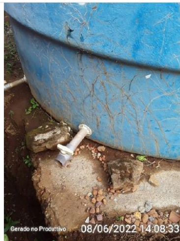
Descarga de fundo do reservatório.
