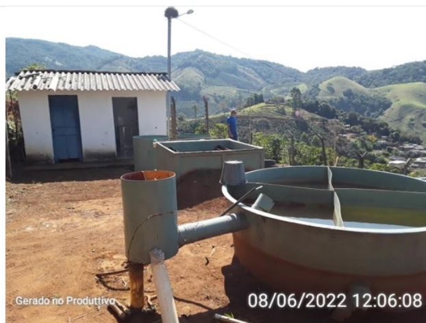
Vista Superior das Estruturas da ETA.
