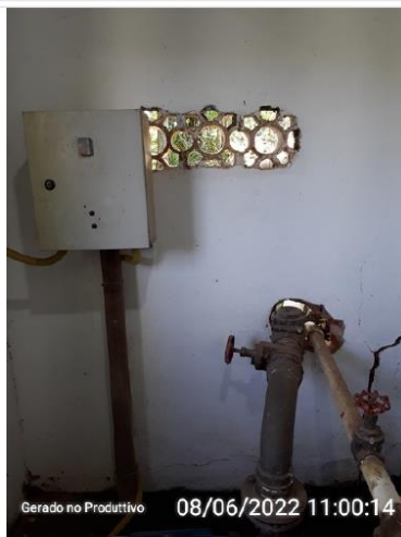
Estrutura na casa de bomba para renovação do ar
