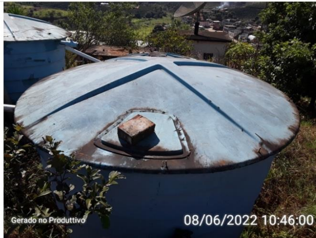
Tampa de inspeção reservatório B.
