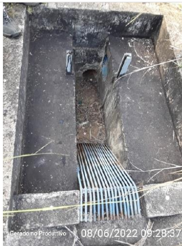
Sistema de gradeamento
