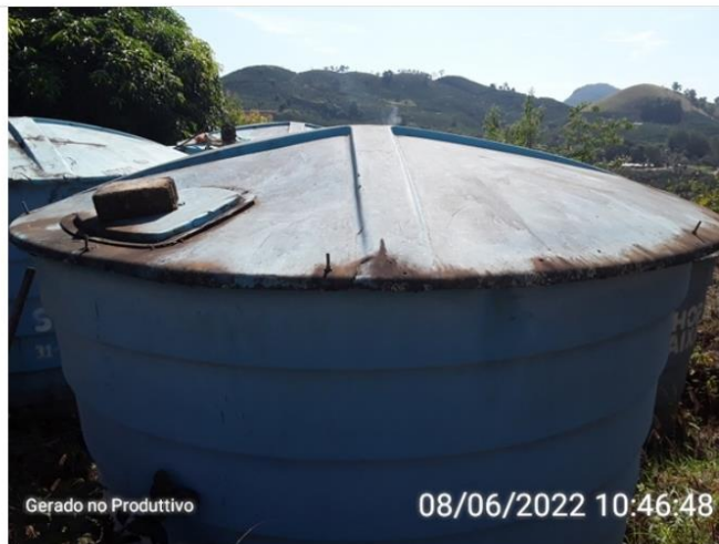
Reservatório B, tampa com lacre de parafusos.
