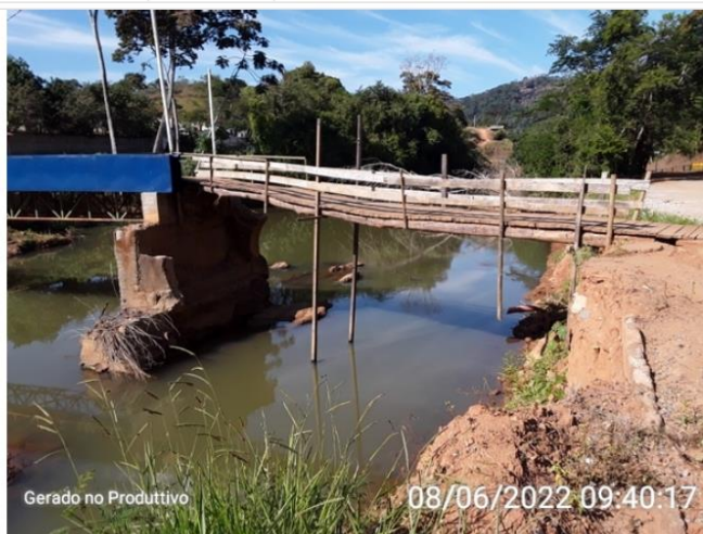
Ponte sobre o curso d'água do município
