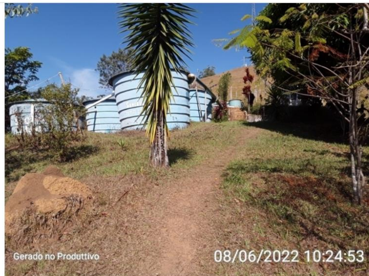
Estruturas dos reservatórios da ETA.
