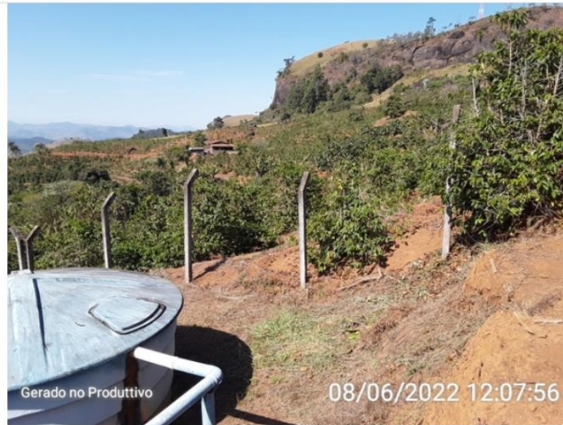
Cercamento ao entorno da área da ETA.
