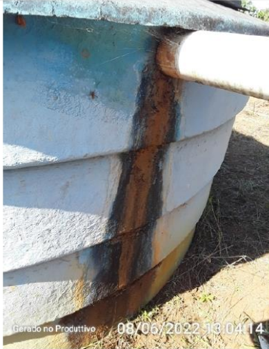
Oxidação da estrutura com vazamentos de água.
