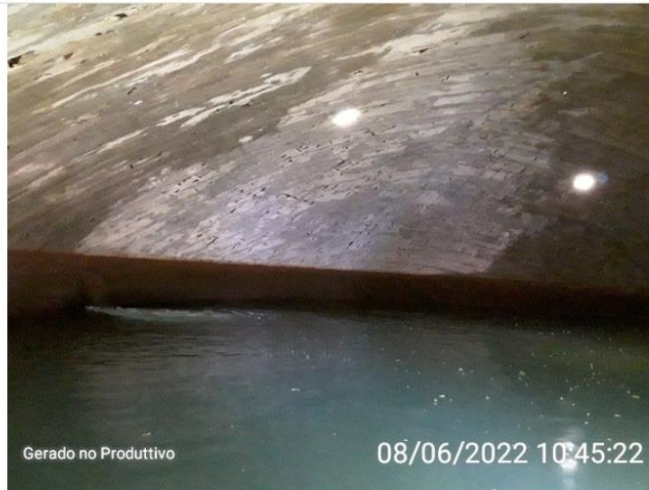
Cobertura do reservatório, vista interior
